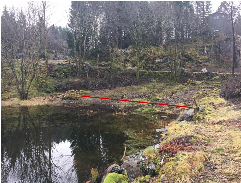
Foto 3 I denne bukten er det nye overløpet tenkt plassert. Vannstand kote 20,2
