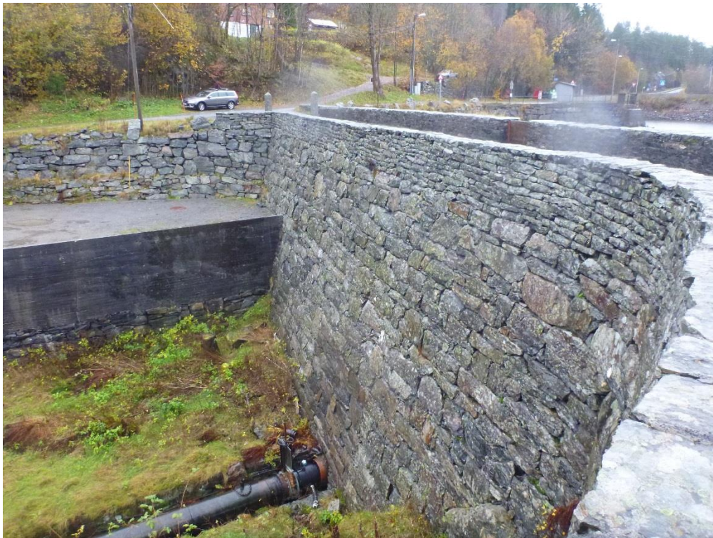
Foto 1 Dam Småvatn sett fra luftsiden.
