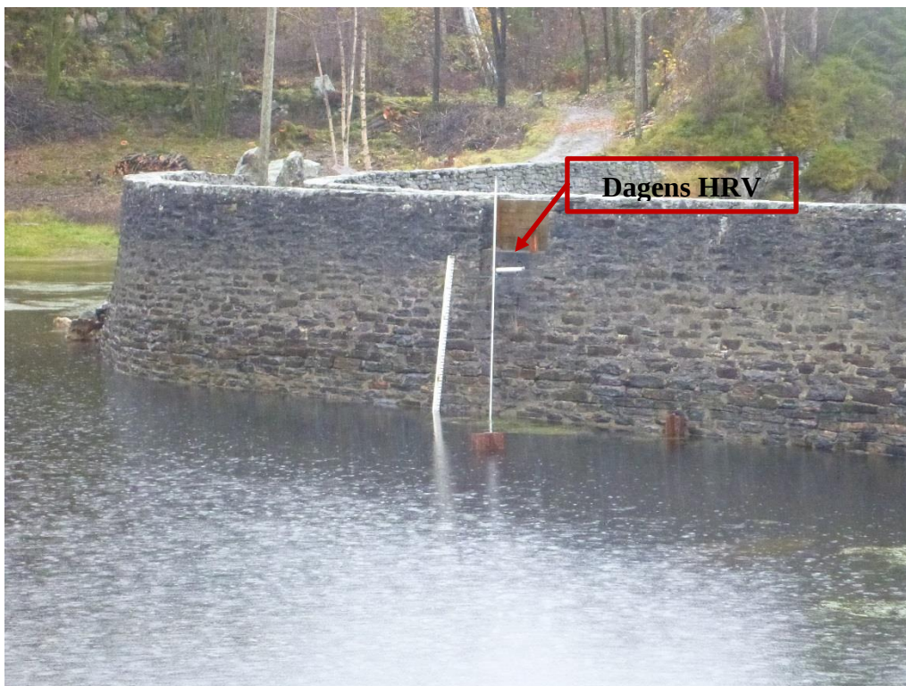
Foto 2 Dam Småvatn sett fra vannsiden. Vannstand kote 18,7
