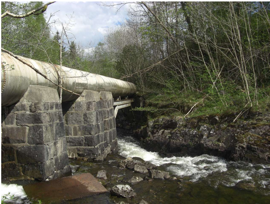
Figur 26. Rør sett nedover mot gammel kraftstasjon
