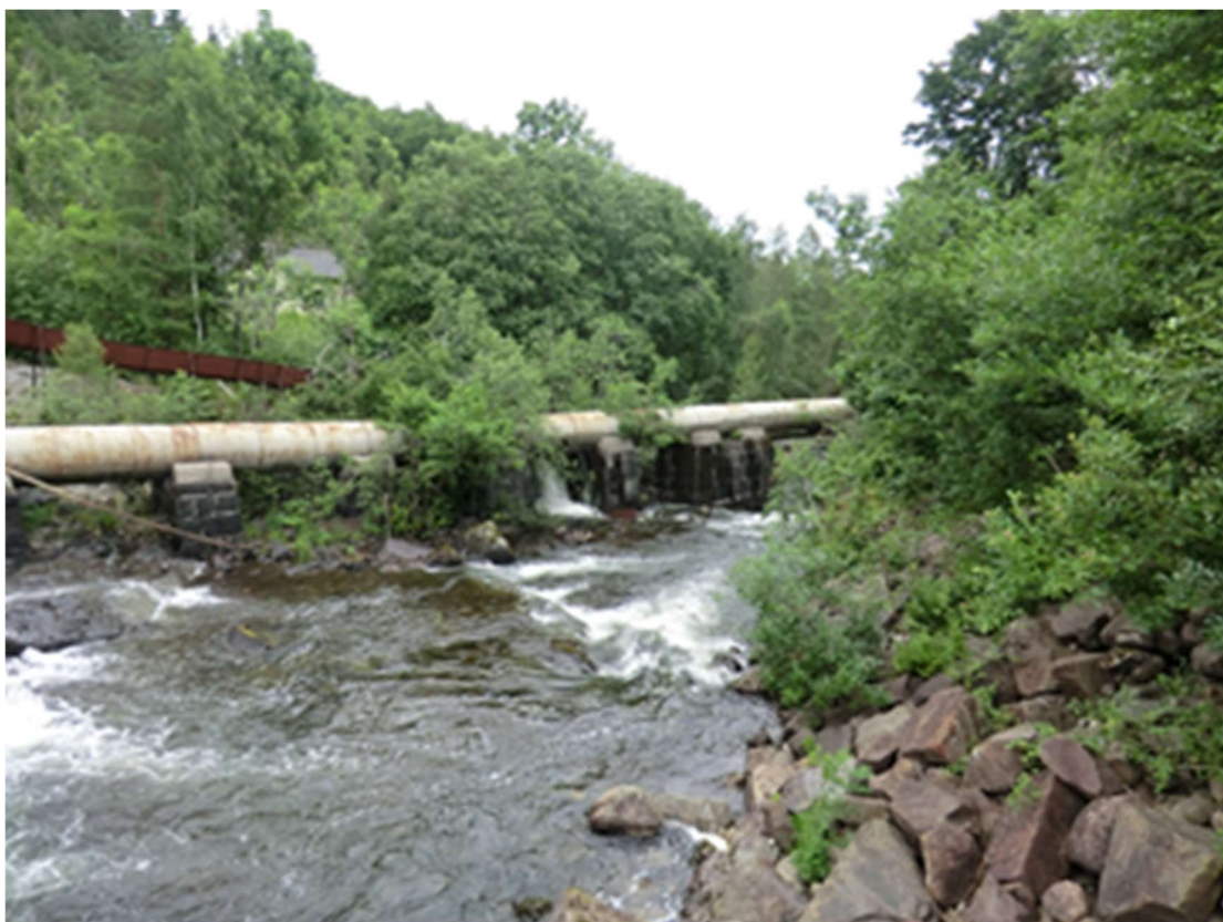
Figur 27. Rør med fundamenter. Gammel tømmerrenne sees i bakgrunnen
