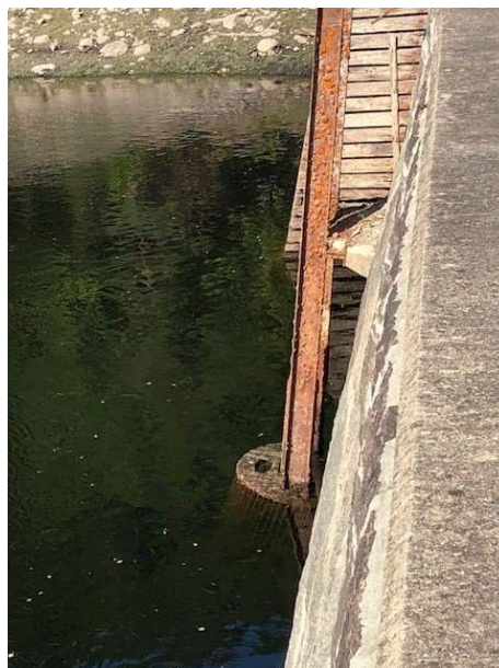
Figur 9. Vannstand ved dam.
