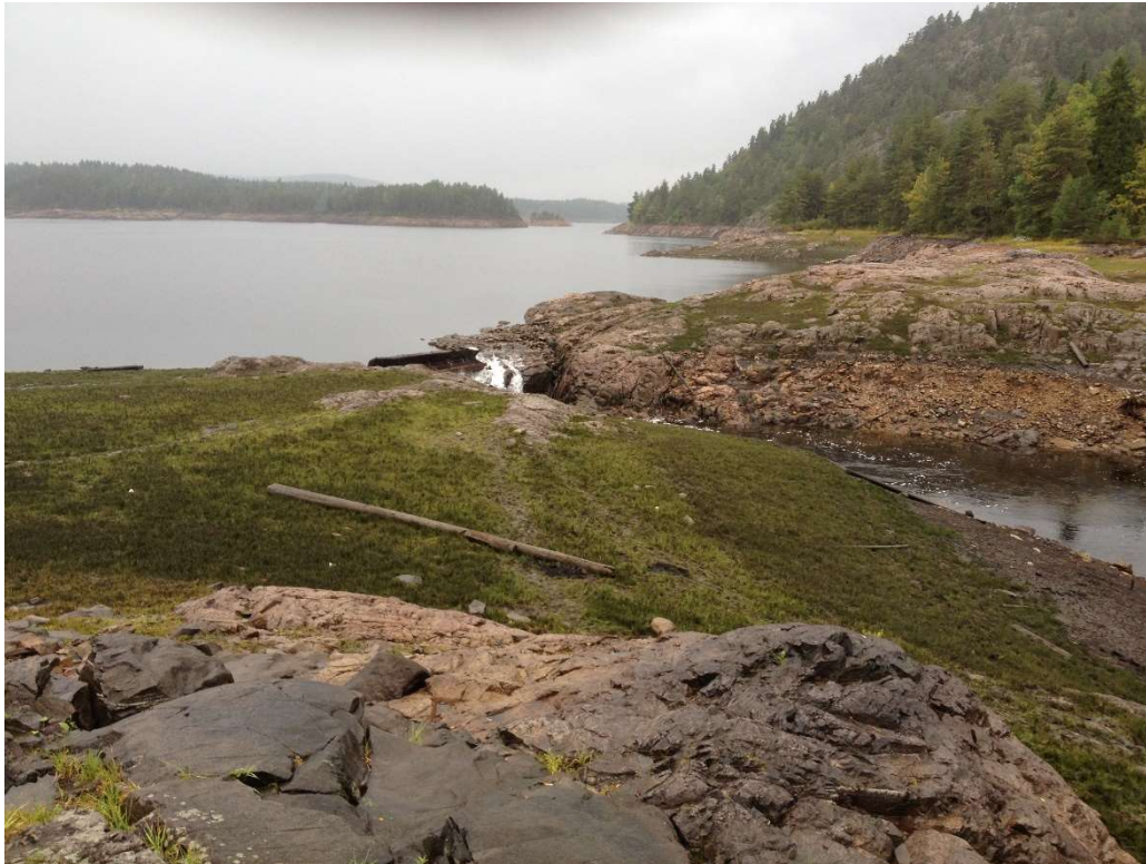
Figur 33. Hellestvedtvann nedtappet. Nålelerskel vises midt i bildet. Der sto den gamle dammen før den nye ble bygget i 1903.
