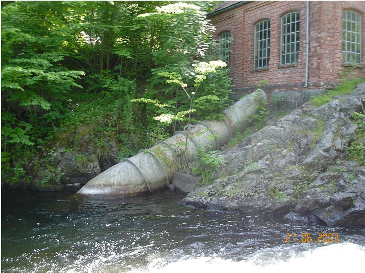
Figur 41 Gammel kraftstasjon med utløpsrør.
