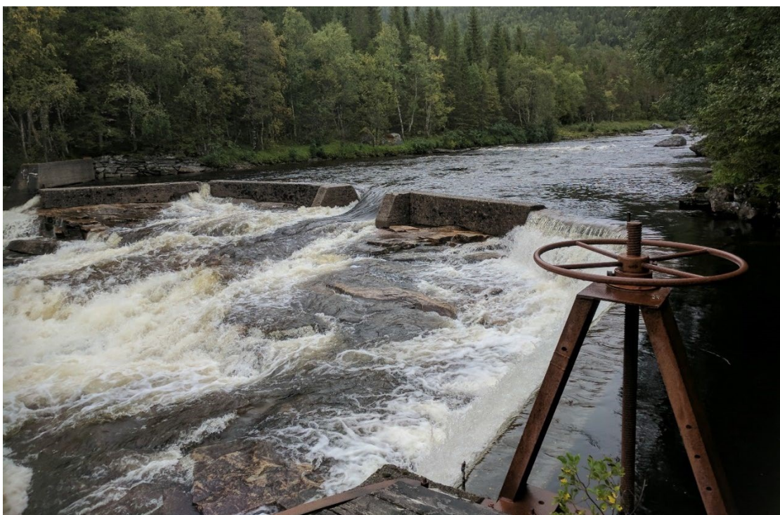
Inntaksdammen må tettes og tilrettelegges for anadrom fiskevandring, men krever ellers ingen større endringer
