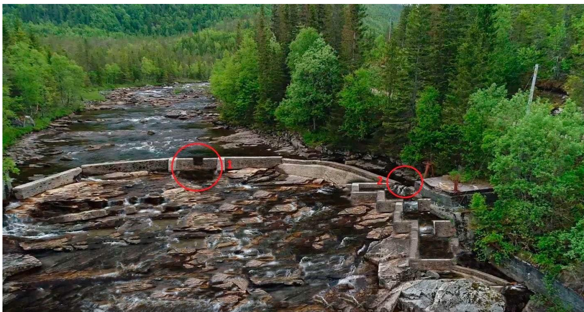
Figur 52. Samme bilde som ovenfor, men der den brede åpningen midt i dammen er erstattet med en smal spalte med høy terskel (1). En tenkt fisketrapp er også manipulert inn i bildet for å illustrere en ny vandringsvei opp og ned (2). I tillegg er vannmengden redusert
