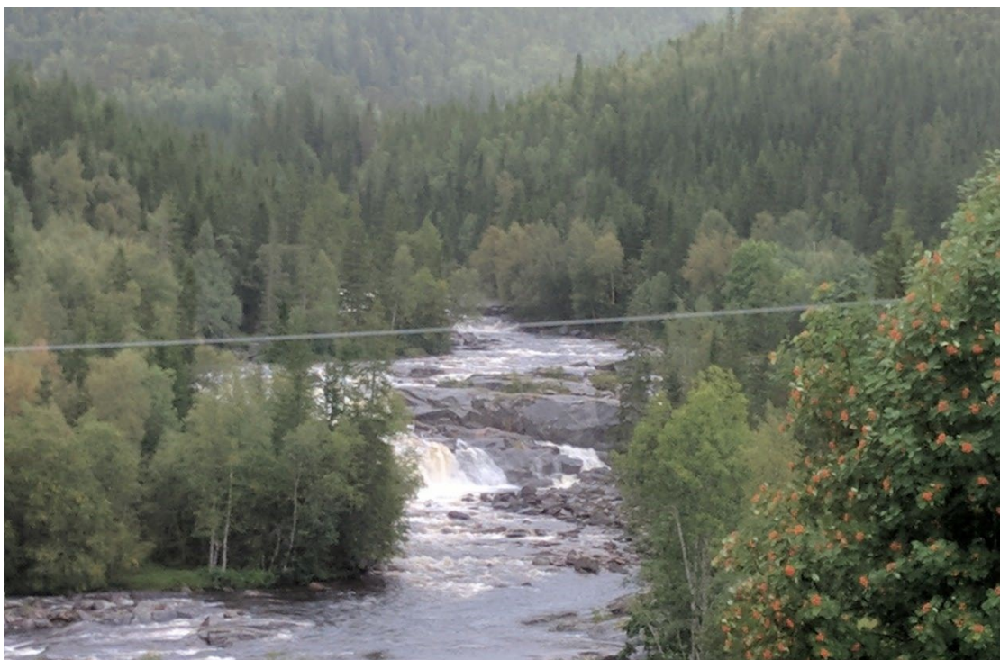
Kvernhusfossen med 22Kv linje i fremkant. Kraftstasjonen er plassert til høyre for fossen. Inntaksdam kan skimtes bakerst
