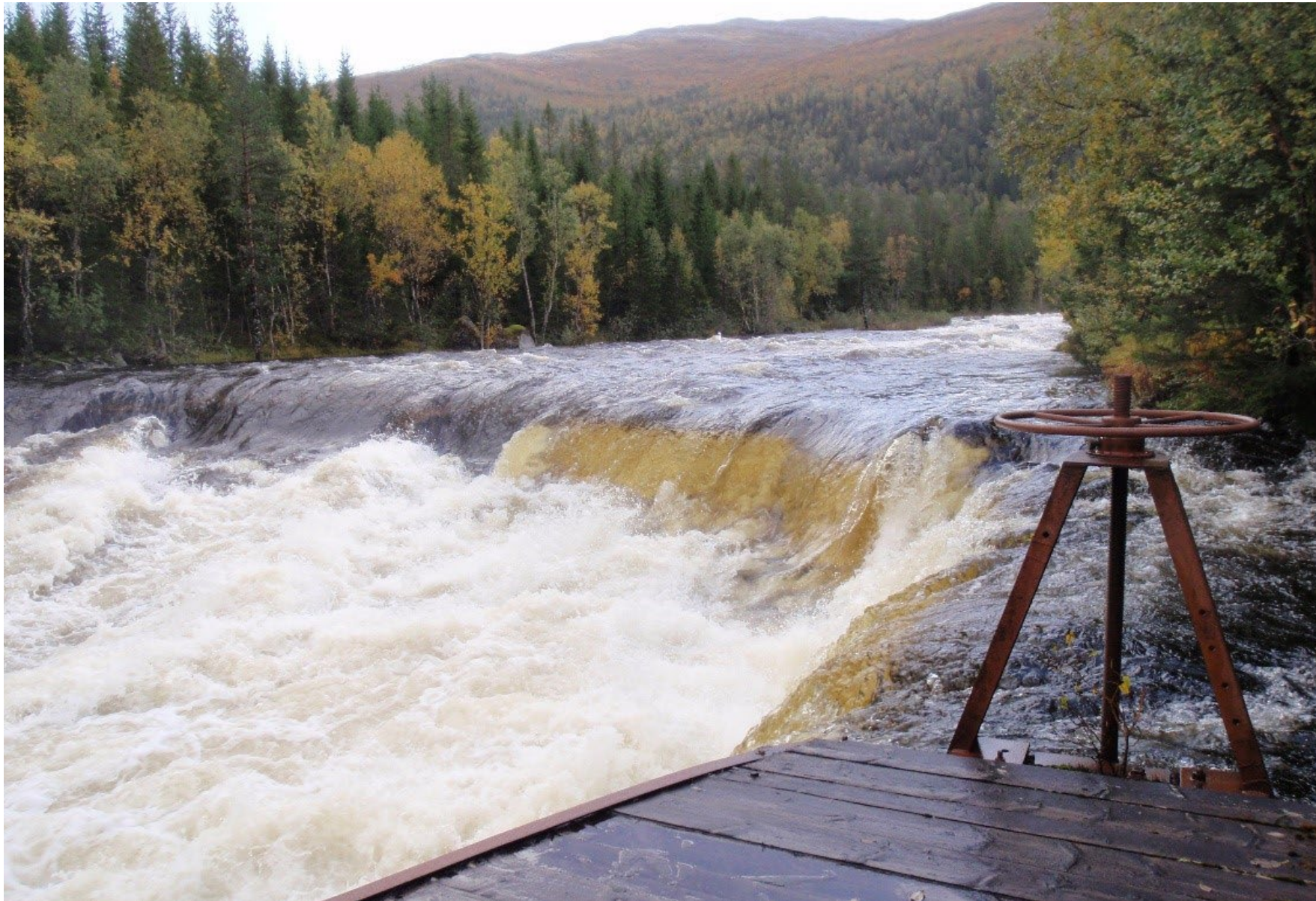
Figur 2. Storflom antatt vannføring ca. 150 m 3 /s. Dato 27.9.2009
