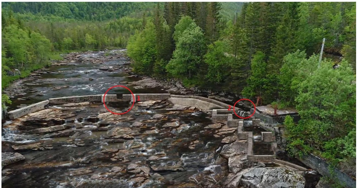
Figur 12. Samme bilde som ovenfor, men der den brede åpningen midt i dammen er erstattet med en smal spalte med høy terskel (1). En tenkt fisketrapp er også manipulert inn i bildet for å illustrere en ny vandringsvei opp og ned (2). I tillegg er vannmengden redusert ved fotomanipulasjon.
