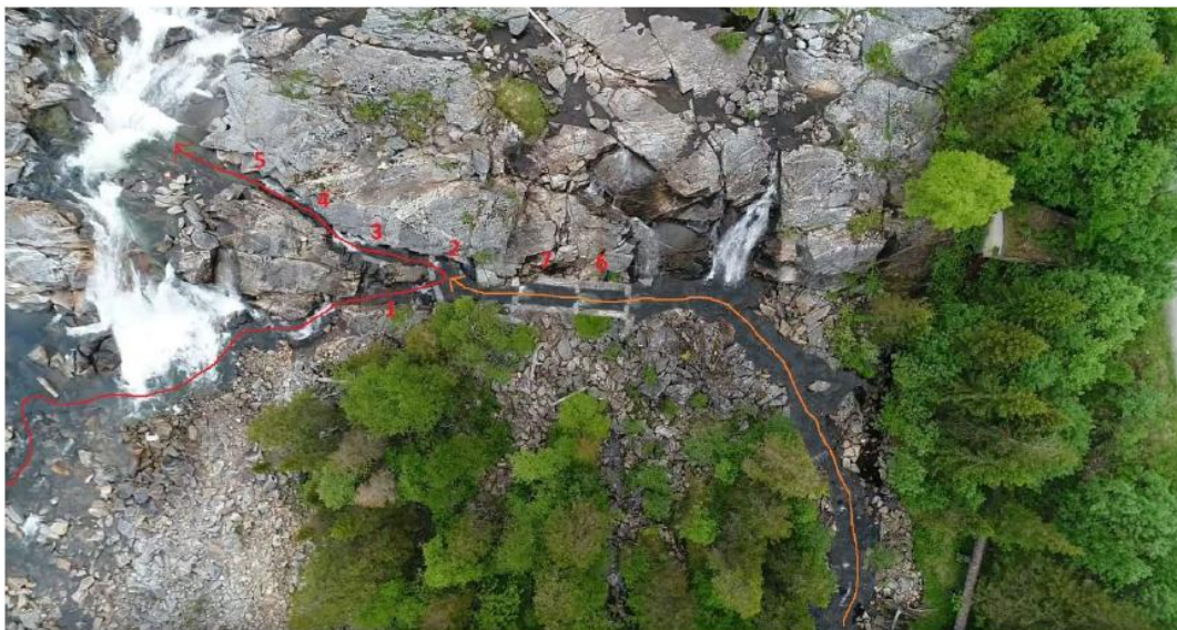
Figur 10. Oversiktsbilde av nedre vandringshinder med dagens vandringsvei for laks og sjøørret (rød strek). Oransje strek indikerer kanal med trinn fra trapp til utløp kraftverk som vil bli etablert ved realisering av kraftverket (Skandinavisk Naturovervåkning 2019).
