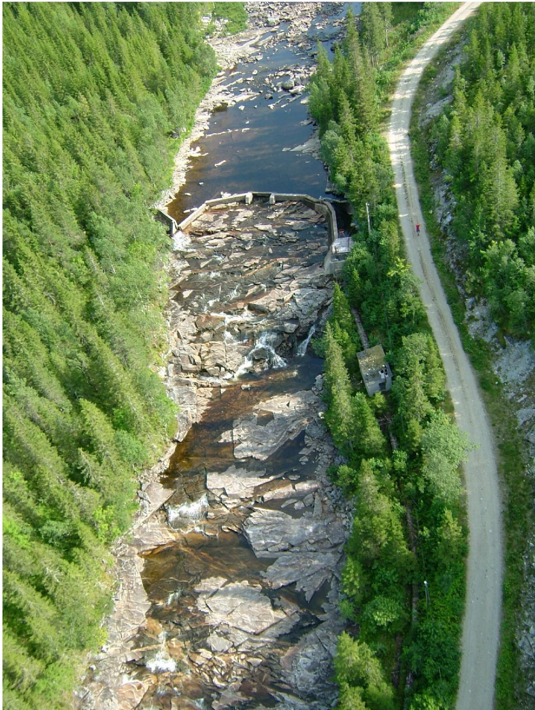
Figur 10. Vandringshinder 5, inntaksdammen for det gamle kraftverket, ca. 1,7 km fra munningen. Bildet er tatt fra helikopter 3.august i 2004 (foto: Frithjof. M. Plahte).
