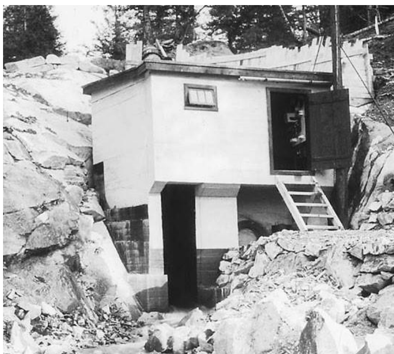
Figur 7. Bilde fra 30-tallet: Eksisterende kraftstasjonsbygning på ca. 11 m 2 før montering av vakuurrør. Installasjonen var en Francis på ca. 55 kW. Vi vil forsøke å bevare den gamle bygningen som et museum. Ny vannvei vil passere på oppsiden av den gamle stasjonsbygningen.
