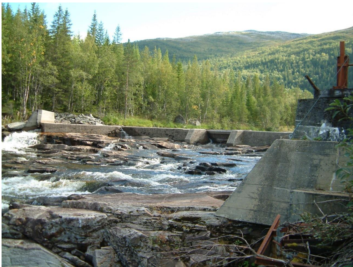
Figur 16. Eksisterende inntaksdam og inntak sett fra undersiden.
