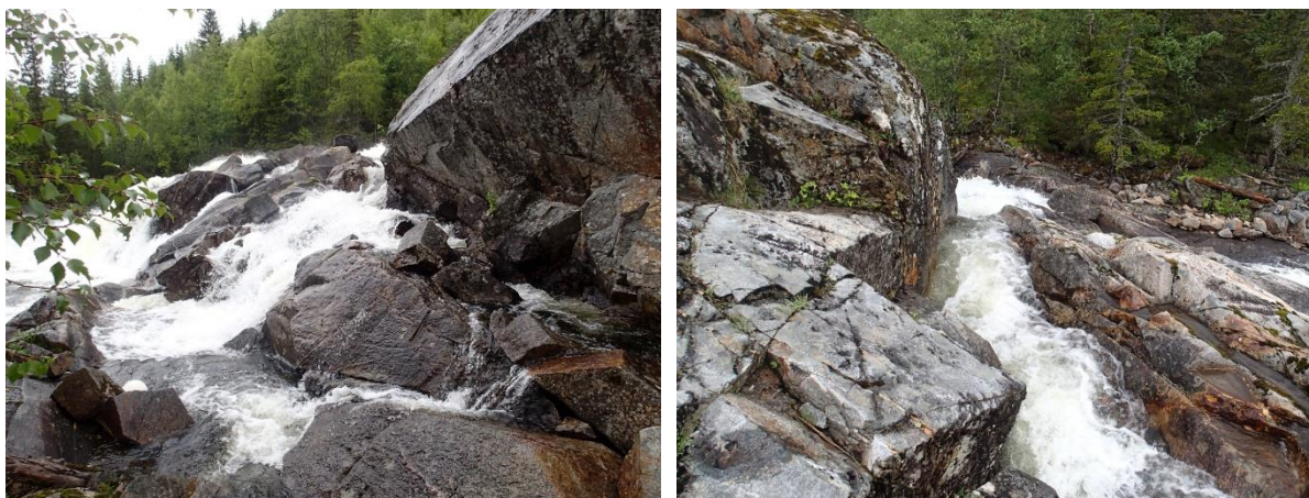
Figur 41. Bilder av fisketrapp i nedre vandringsutfordring. Venstre bilde er tatt fra siden av trappen der fisken vandrer fra venstre, via passasjen i forkant av bildet og videre opp langs berget til høyre. Høyre bilde viser fisketrappen ovenfra.
