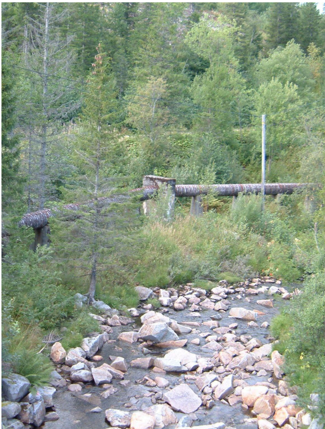
Figur 45. Turbinrør i treverk til nedre kraftstasjon. En bit av rørene vil bli beholdt som kulturminne.
