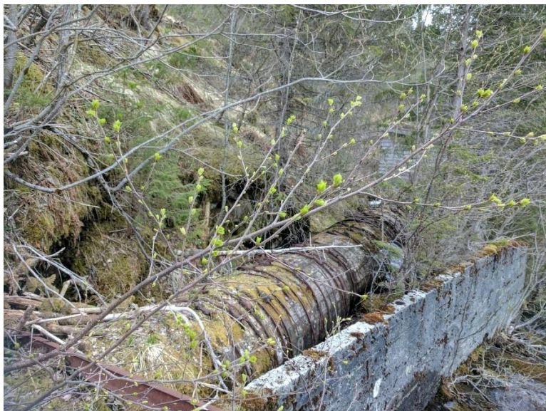
Figur 18. Det gamle turbinrøret ble produsert lokalt og er laget i tre.
