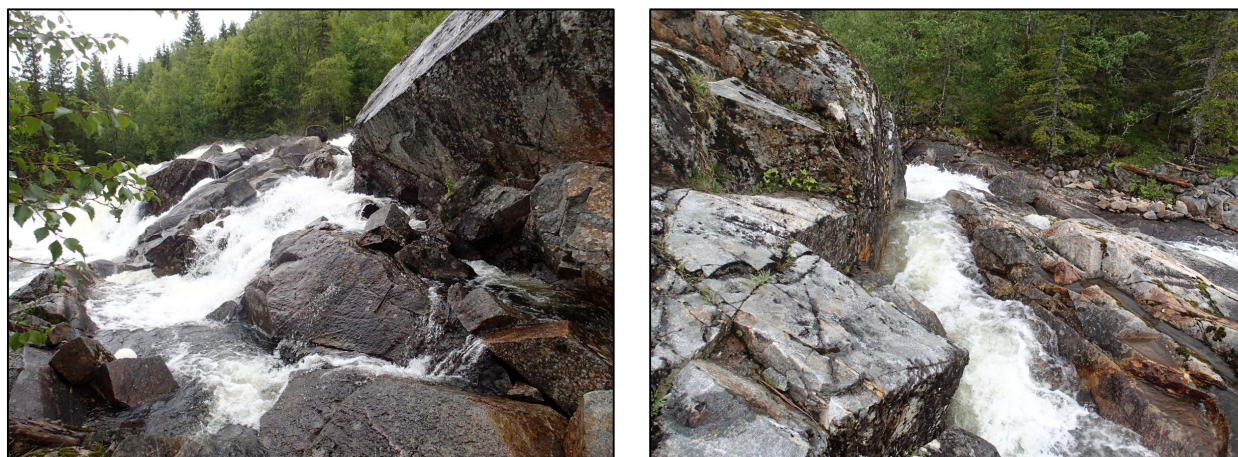
Figur 8. Bilder av fisketrapp i nedre vandringsutfordring. Venstre bilde er tatt fra siden av trappen der fisken vandrer fra venstre, via passasjen i forkant av bildet og videre opp langs berget til høyre. Høyre bilde viser fisketrappen ovenfra.
