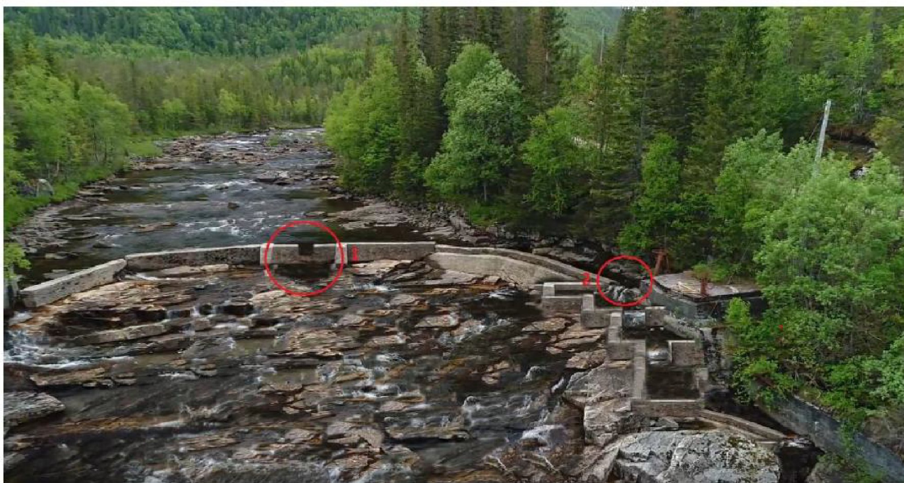
Figur 9. Visualisering av fisketrapp og forminskning av åpning i dam (Skandinavisk Naturovervåking 2019).
