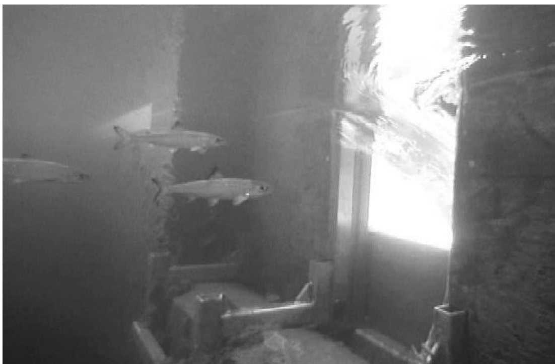
Figur 47. Laksesmolt på vei ned mot det øverste trinnet i ei fisketrapp. Tilstrekkelig vannhøyde i trinnet gjør at fisken ikke nøler med å vandre gjennom en slik spalte.
