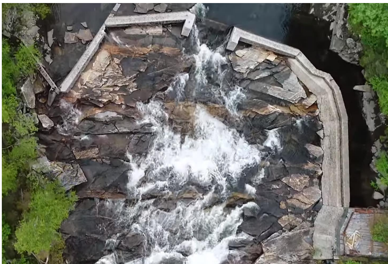
Figur 15: Eksisterende inntaksdam sett ovenfra.
