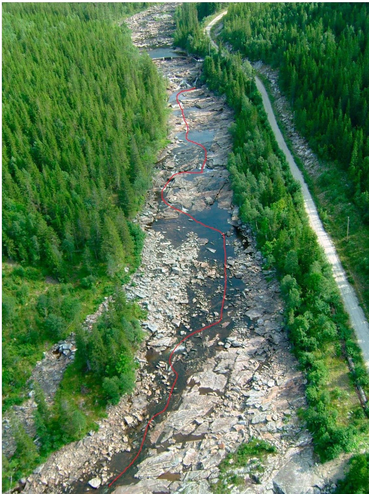
Figur 54. Øvre del av minstevannstrekningen med inntegnet mulig vandningsrute med rød strek. Vannføringen på datoen bildet ble tatt, var ca. 100 l/s og derved mindre enn planlagt minstevannføring om vinteren.
