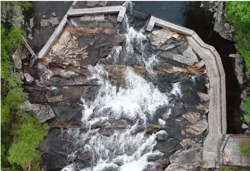
Figur 3. Eksisterende inntaksdam sett ovenfra.
