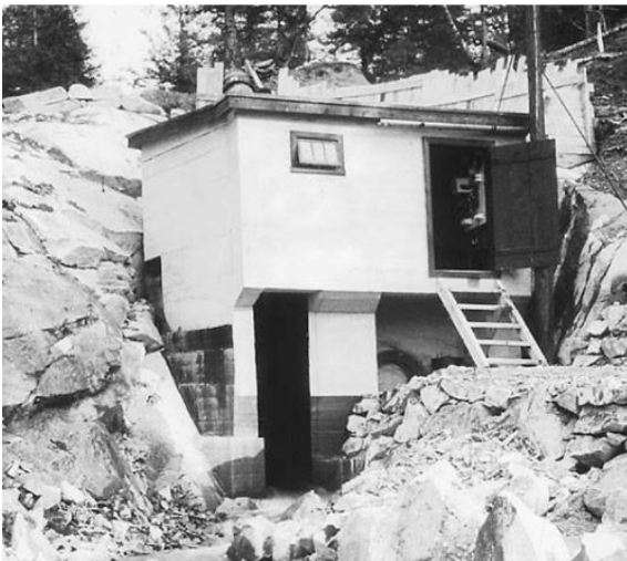
Figur 4. Eksisterende kraftstasjonsbygning på ca. 11 m 2 før montering av vakuumbør. Bildet er tatt på 30-tallet. Tiltakshaver ønsker å bevare bygningen som et museum.
