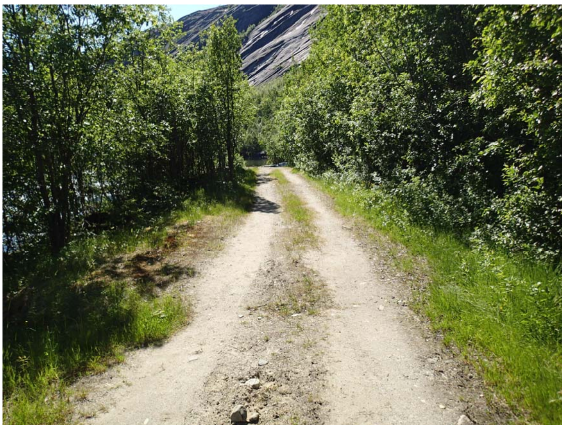
Figur 6 Eksisterende vei til planlagt inntak
