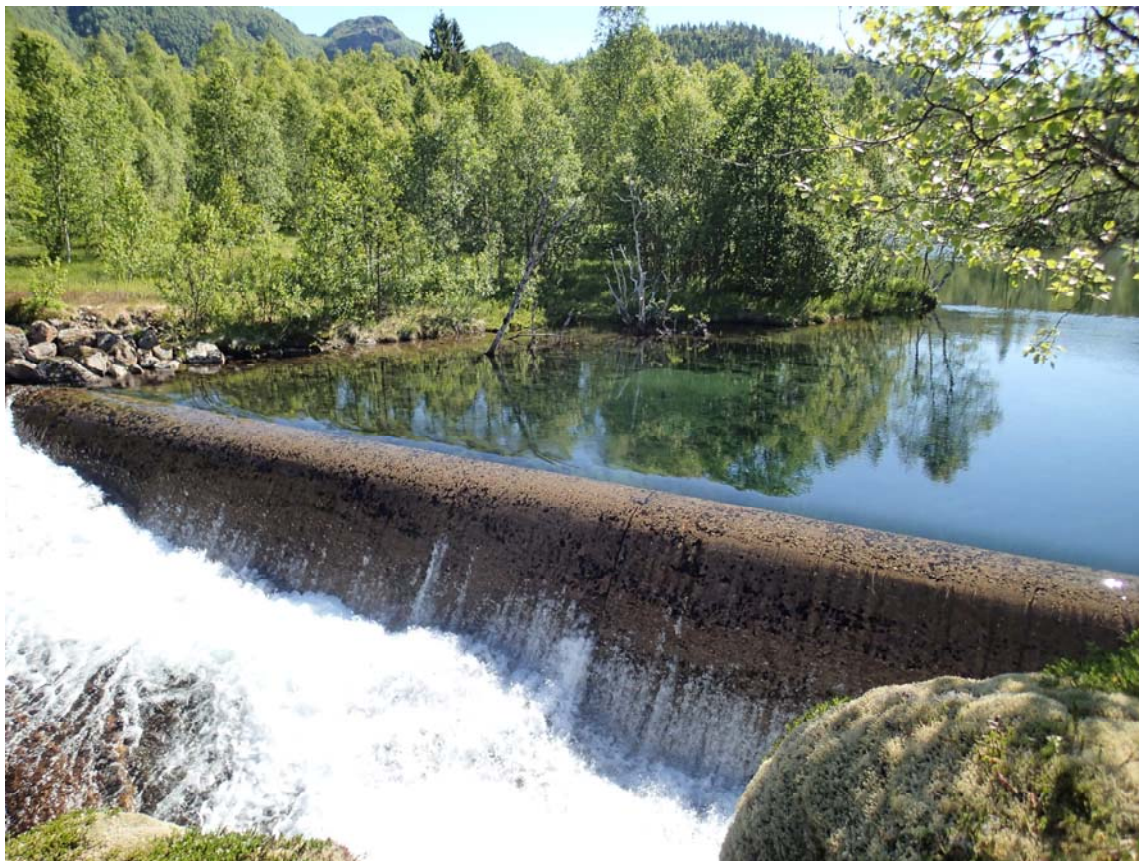
Figur 9 Eksisterende dam i Sørfjordelva kote 50
