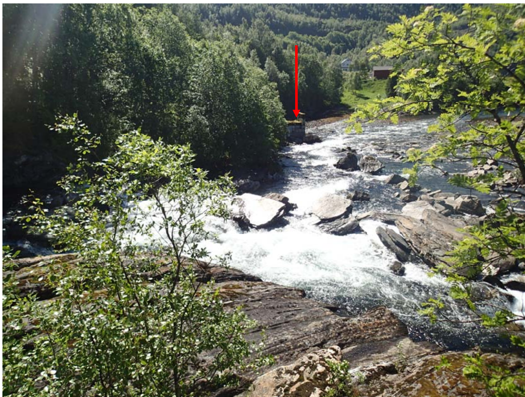
Figur 16 Det står igjen rester etter bygning anvist med rød pil.
