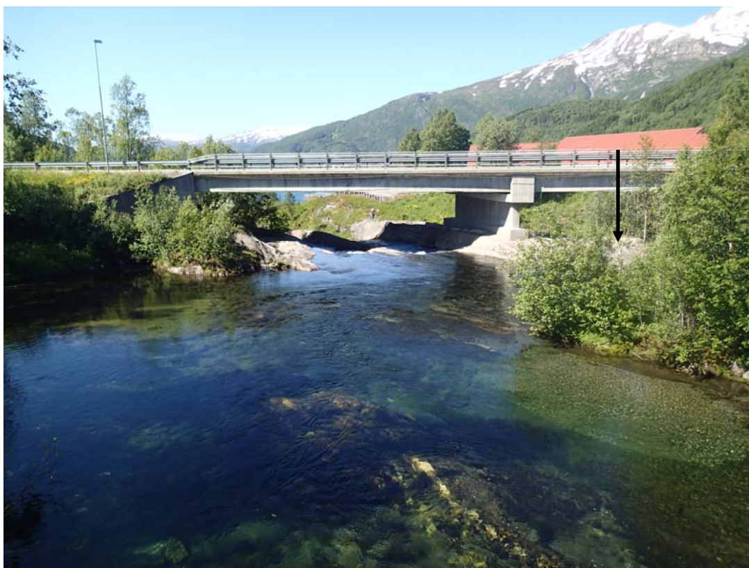
Figur 15 E6 bru over Sørkjordelva. Planlagt inntak minikraftverk, stamfiskanlegg kote 24 anvist med pil. Kraftstasjon vil være i inntaksbygget.
