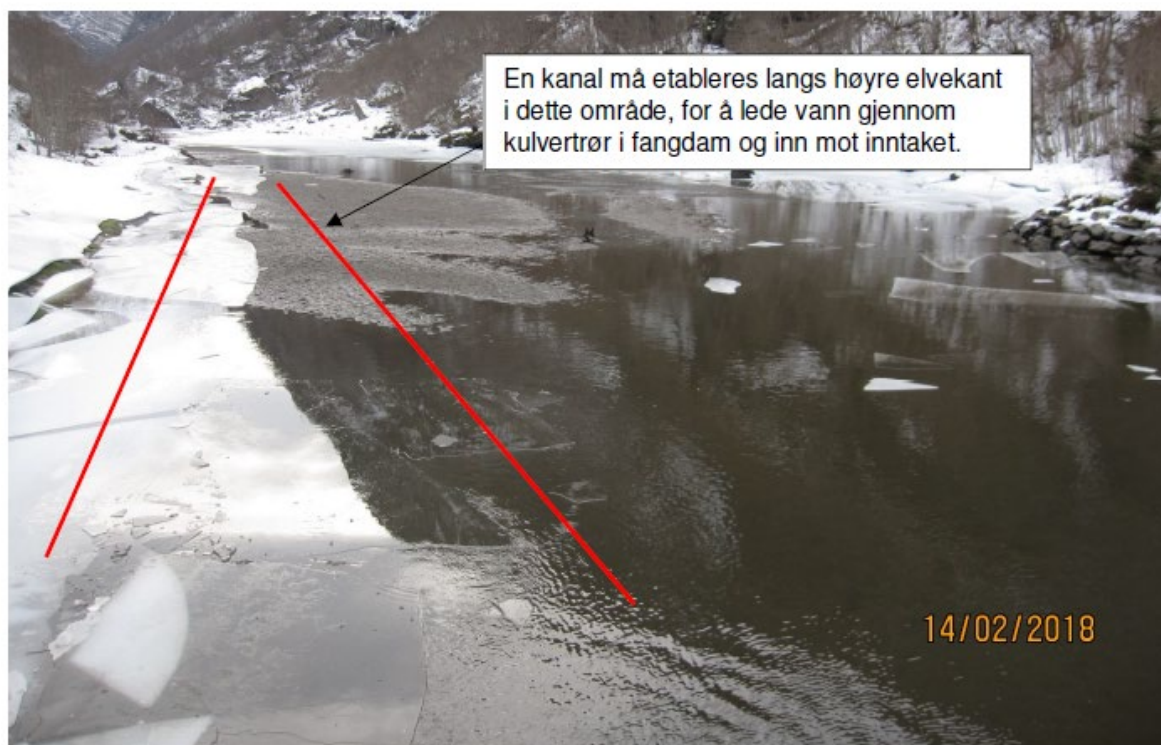
Figur 6-5. Bilde av magasinet, sett fra inntaket ved en vannstand på ca. kote 88,8. Merk at sediment vises tydelig like oppstrøms dammen. Det må etableres en grøft/kanal for å lede vann inn mot inntaket, gjennom kulvertrør.
