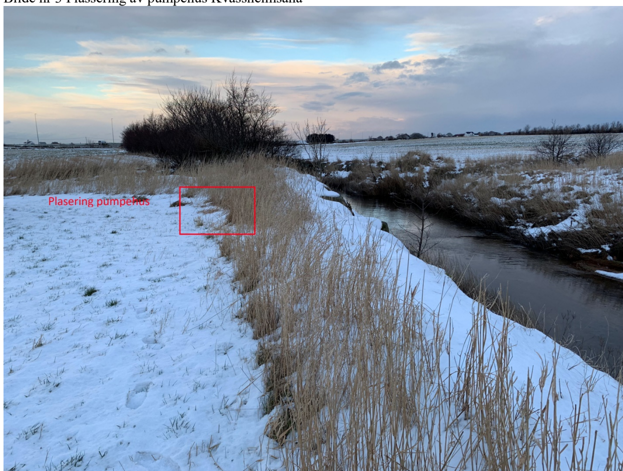
Bilde nr 3 Plassering av pumpehus Kvassheimsåna
