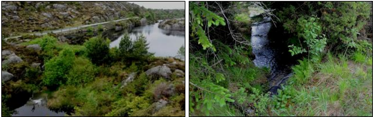
Figur 6. Dammen i utløpet av Bjørndalsvatnet sett mot nord og utover innsjøen ( dam 4 ) (venstre) og utløpselven ned til Brakedalsvatnet (til høyre).
