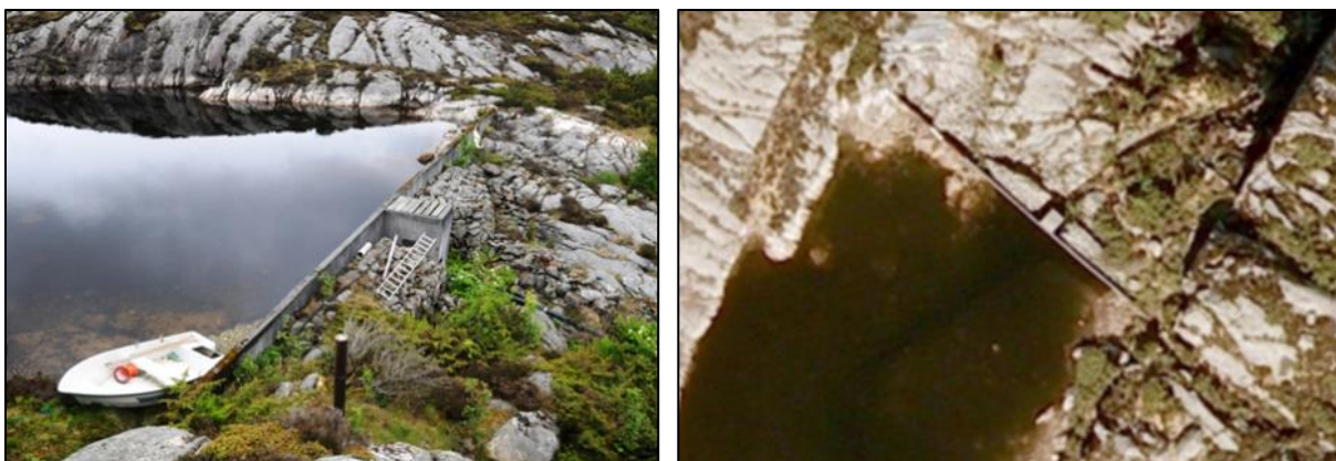
Figur 4. Demning i Brakedalsvatnet ( dam 1 ) venstre og silanlegget i betonganlegget.
