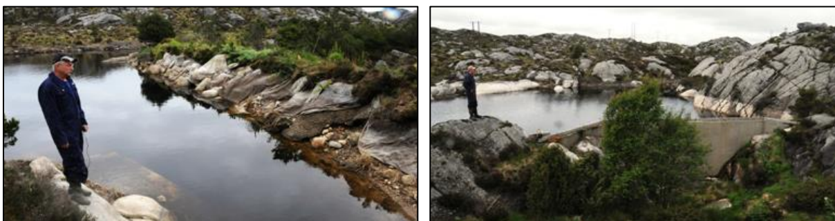
Figur 5. Demningen i Søre Øykjadalsvatnet ( dam 2 ) (venstre) og i Nordre Øykjadalsvatnet ( dam 3 ) (høyre).
