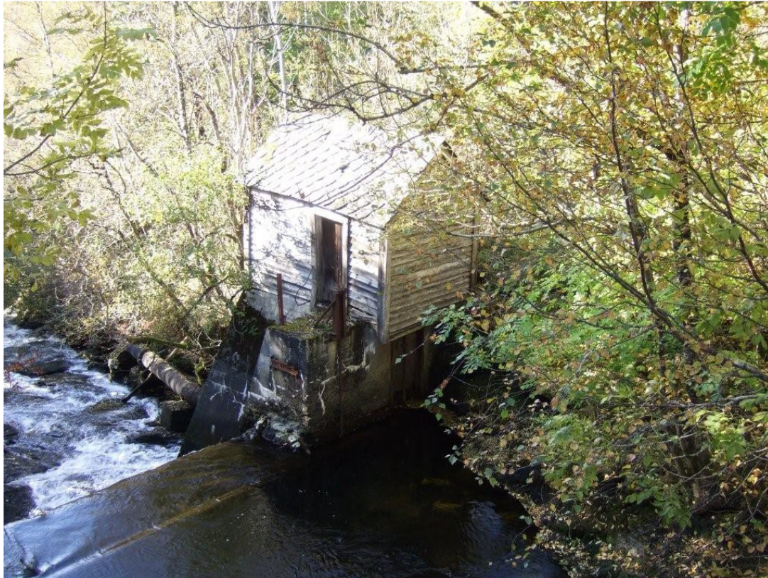
Fotoet er tatt mot NV og viser det gamle lukehuset for det gamle kraftverket. Det nye inntaket er planlagt med innløp oppstrøms lukehuset og plassert i terrenget bak lukehuset.
