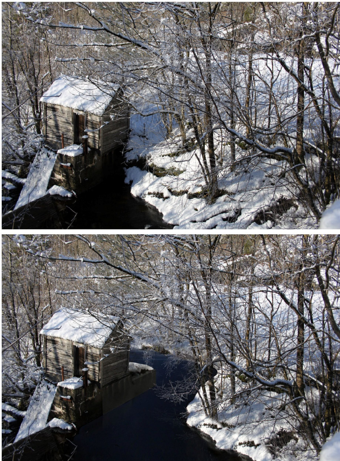
Bilde 2. Eksisterende dam nedstrøms Herandsvatnet før og etter utbygging.
