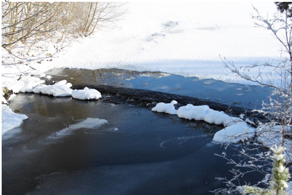
Bilde 3. Eksisterende terskel i Herandsvatnet.
