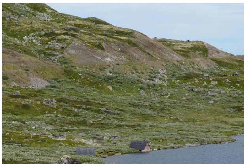
Figur 4.7. Noen inngrep blir kanskje aldri revegetert. Som her ved Halnefjorden R7 på Hardangervidda. Vegskjæringen har delvis ustabile masser som gir vanskelige etablerings- og vokseforhold for planter. Foto: A. B. Skrindo.
