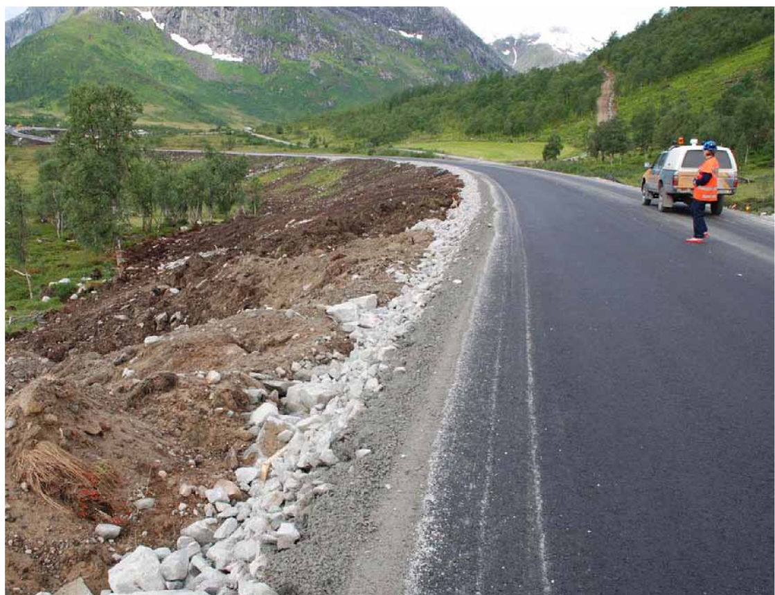
Figur 9.5 B. Jordbehandling -Naturlig gjenvekst fra stedlige toppmasser. Tilbakelegging av masser langs ved utbyggingen av Lofast (E10). Massene nærmest fotografen er ikke ferdig utlagt. Foto: A. B. Skrindo.
