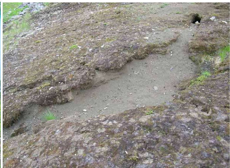
Figur 7.2. Ustabile masser fører lett til erosjonsfurer i vegskråninger. Steinfylling langs E10 Lofast er dekket med humusholdig jord lagt lett oppå fyllinga, og dette har vist seg å gi stabile masser. Foto: A. B. Skrindo.
