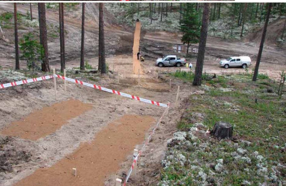
Figur 9.10. Organiske matter av kokosfibre er lette å legge på, og de stabiliserer overflata. Også på svært skrinn jord. Matta må festes godt til bakken dersom den skal fungere optimalt. Metoden er relativt kostbar, men kan være aktuell på mindre områder med spesielle utfordringer. Foto: D. Hagen.
