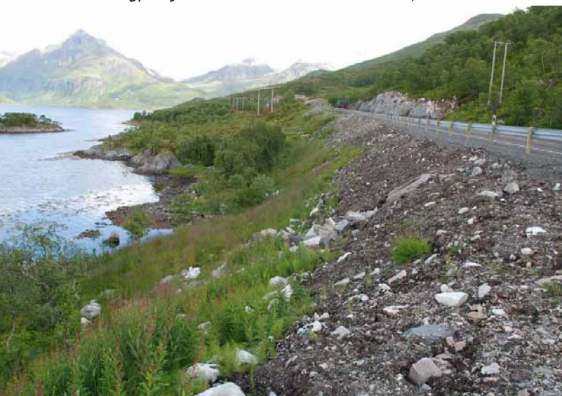
Figur 9.4. Jordbehandling "Naturlig gjenvekst fra stedlige toppmasser" fra Øksfjorden, vegprosjektet Lofast E10. A er fra 2005, B er fra samme sted 2008. Foto: A.B. Skrindo.
