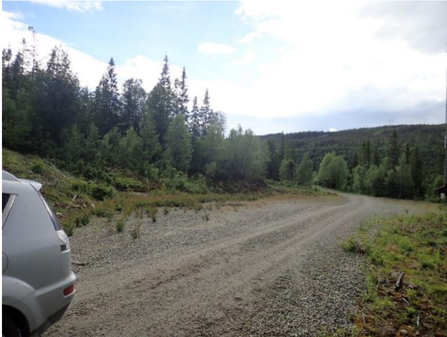
Figur 13 Riggclass 18 Ved antennemast Usmedalen
