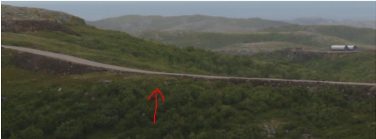
Figur 3 viser et eksempel hvor en vei er bygget på fylling, men hvor terrenget bryter fyllingen og hvor resultatet er en vei godt tilpasset landskapet
