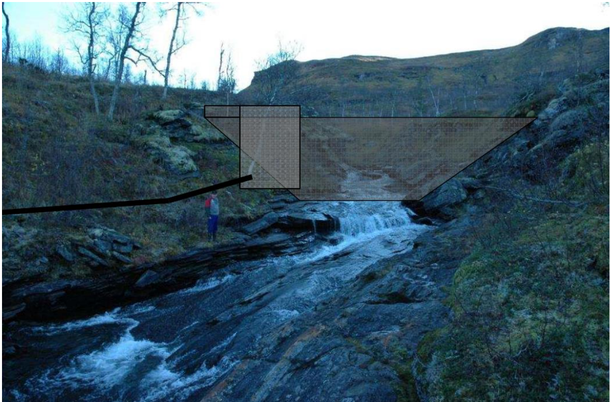
Figur 1 - Inntaksområde. Dam, inntak og rørgate skissert. Vannføring ca. 0,3 \text{ m}^3/\text{s}
