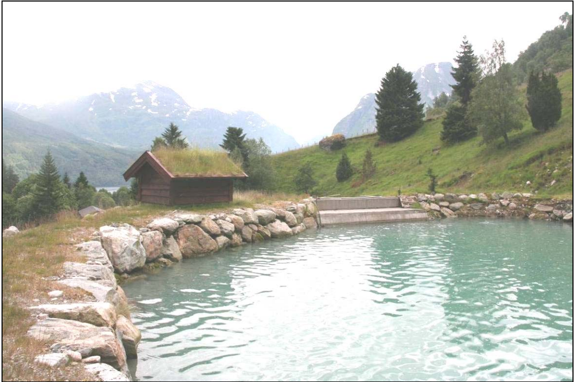
Figur 5. Kraftstasjonen er planlagt på ryggen i bakgrunnen, kote 200, mens avløpsvannet blir ført tilbake til eksisterende inntaksdam til Neselva I kraftverk i forgrunnen, kote 195, via en nedgravd betongkulvert med diameter 1,2 m (foto 13. juli 2008: Ole Kristian Spikkeland).
