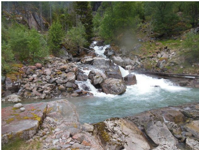
Medel sommarvassføring 3,5 m 3 /s ved kraftstasjonen
