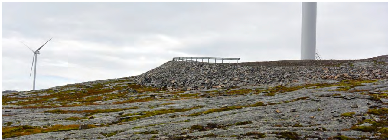
Bilde 4 viser hvordan en relativt ryddig, godt pakka steinfylling fremstår som en veltilpasset konstruksjon i et område med mye fjell i dagen.
