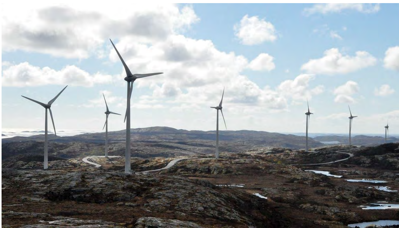
Bilde 7. Bildet viser hvordan et godt tilpasset vegnett slynger seg med terrenget.
