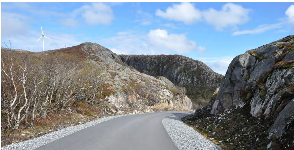
Figur 18. Dersom vegen må føres gjennom fjellparti og tosidige skjæringar ikke kan unngås, er det viktig at det settes av nok plass til at tverrsnittet føles romslig og skjæringene kan bearbeides i bunn og topp for å minske deres visuelle høyde og myke opp profilet. (Originalbilde fra asfaltert adkomstveg til vindkraftverket på Ytter Vikna)
