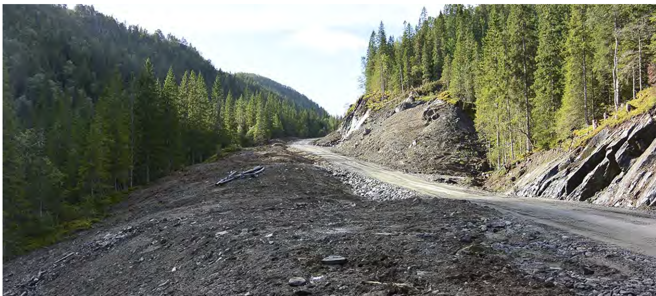
Bilde 8 viser området etter sluttarrondering, Kløfta er fylt opp og skråningene er slaka ut. Vegen har fått en god forankring inn mot nytt terreng og virkningen av inngrepet er dempet.
