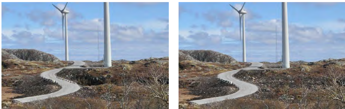
Figur 9. I det fotomanipulerte eksempelet er det fylt igjen masser i et dalsøkk foran fremre turbin. Inngrepene samles samtidig som vegen gis en bedre forankring i landskapet ved å unngå fyllingsskråning på begge sider av vegen og kranoppstillingsplassfor turbinen blir mindre ruvende.
