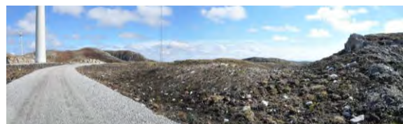
Figur 6. Det er viktig at arronderte områder ikke blir helt flate, men at de gjenspeiler variasjonene i tilliggende terreng. På bildet til venstre fremstår istandsatt massetak som ei litt for stor og ensarta flate til at den visuelt aksepteres som en naturlig formasjon i det småkuperte terrenget. Eksisterende situasjon Ytre Vikna. Fotomanipulert bilde til høyre viser at en mindre overhøyde på deler av arrondert terreng kan være alt som skal til for et mer naturlikt landskapsbilde
