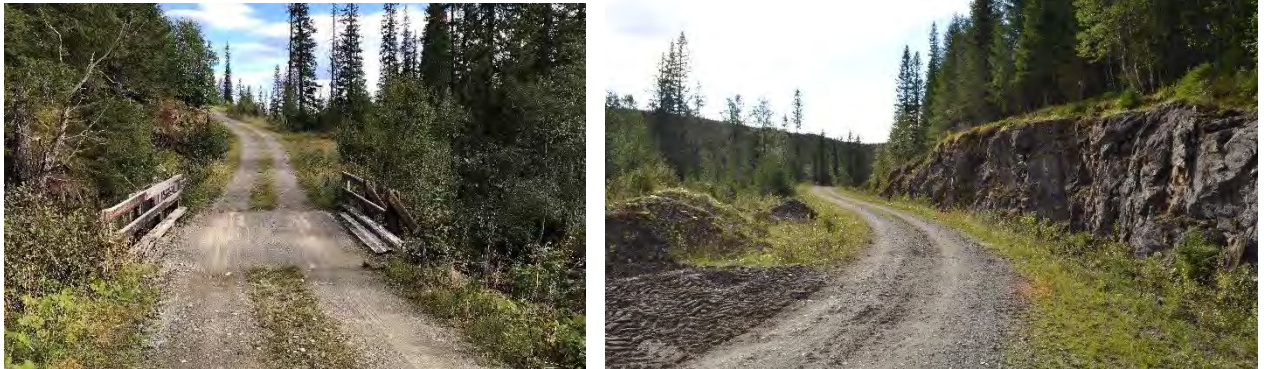
Bilde 14 Bro over Kalvåa sett sørfra og nordover. Bildet til høyre viser dagens skjæring i forlengelse av brukryssing av elva.
