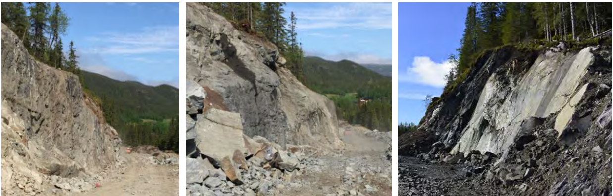
Bilde 9 viser et konturborra parti til venstre med mer monotont uttrykk og hardere overgang til eksisterende terreng. Bildet i midten og bildet til høyre gir et rolig inntrykk med mjuke overganger opp mot eksisterende terreng.
