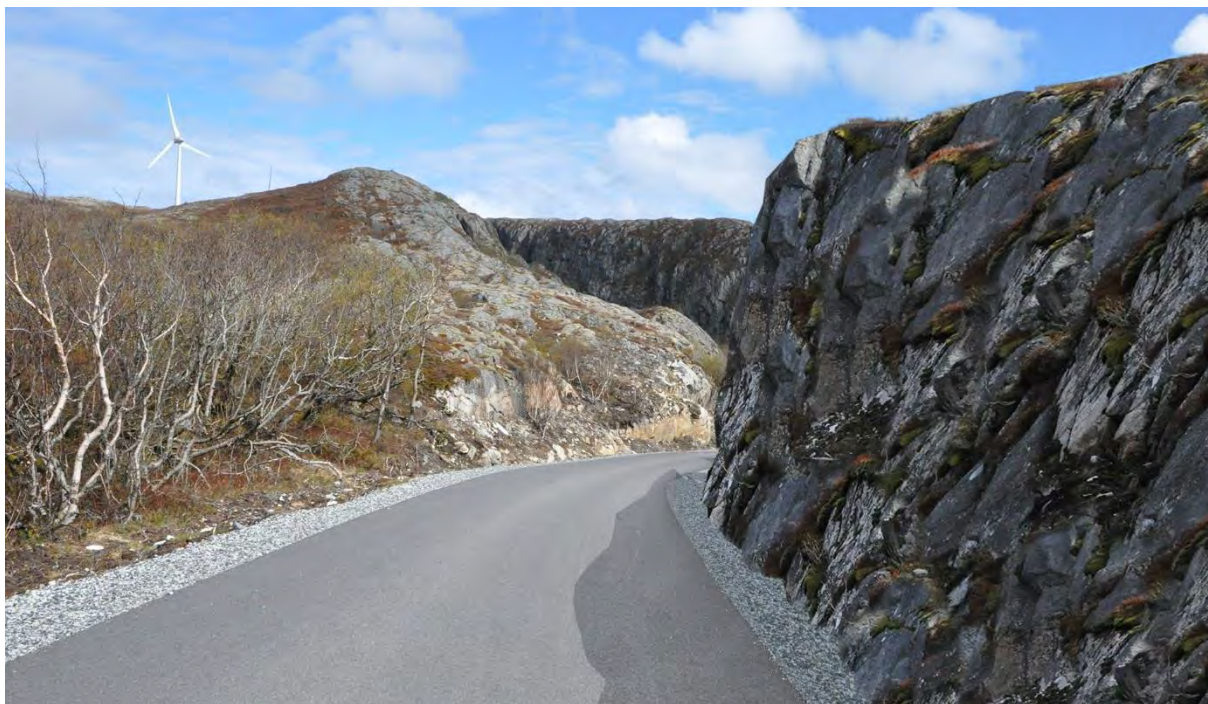
Figur 17. Manipulert bilde viser en tosidig skjæring der det ikke er gjort tiltak for å dempe den visuelle virkningen av skjæringen til høyre i bildet.
