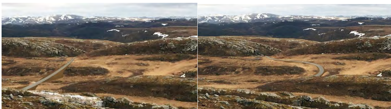
Figur 14. Bildene viser illustrasjoner av de to veglinjene og hvordan den rette linja bryter med terrengformene og med det blir mer visuelt framtrædende enn linja som følger terrengformene.
