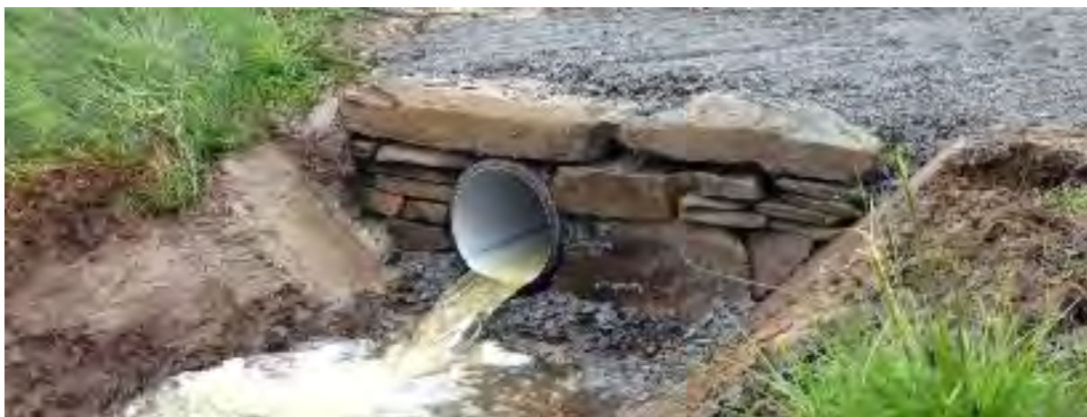
Bilde 16 viser en god bearbeiding inn mot stikkrenna. Grad av opparbeiding må tilpasses sted og eksponering.
