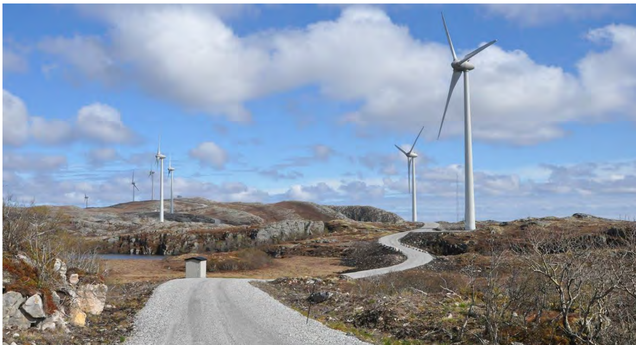
Bilde 6. I det småkuperte landskapet er økt veglengde å foretrekke foran skjæringer. I tillegg kan traseen med fordel legges med litt høyde i terrenget, da fyllinger i prinsippet lettere kan gis en naturlig tilpassing enn skjæringer.
