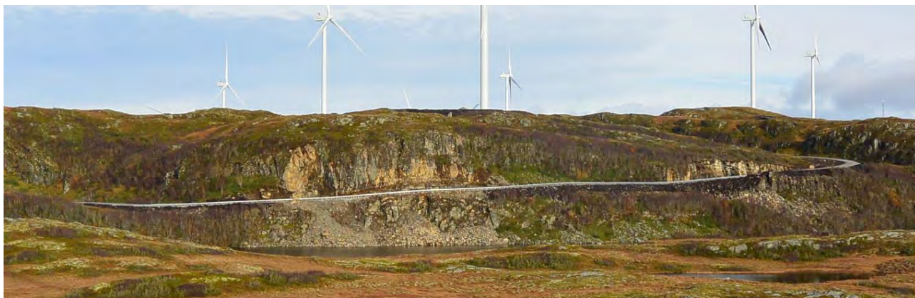
Bilde 5 viser nytt løsmateriale i foten av en fjellskjæring som er lagt inn mot en naturlig skrent. Disse har et uttrykk som ligner de naturlige rasurene som ligger like til høyre for de nye.
