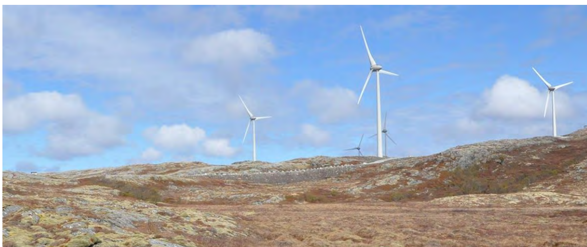
Figur 8. Jordfargen på vegskråningen skiller seg noe ut fra tilliggende terreng, men vil på sikt bli lite synlig med reetablert lyng og mose som på tilliggende areal.
