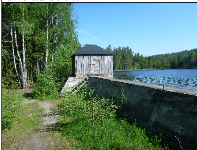
Dam og lukehus sett fra flomløp
