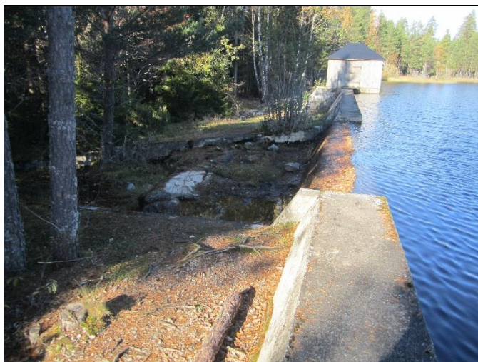
Dammen sett fra venstre side. Lukehus og flomløp.
