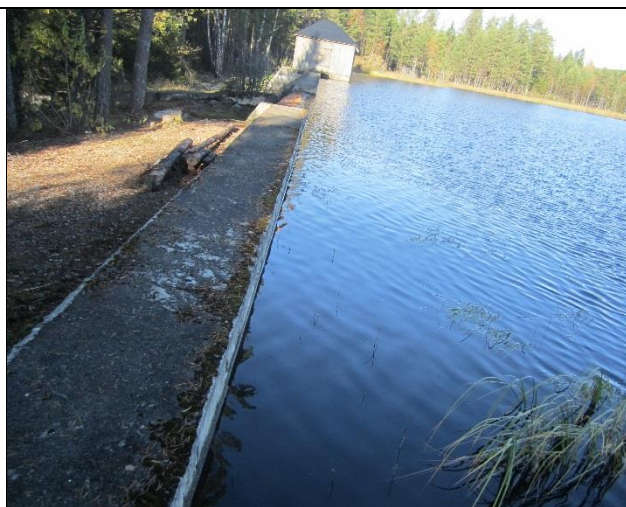
Dammen sett fra venstre side. Lukehus og flomløp.
