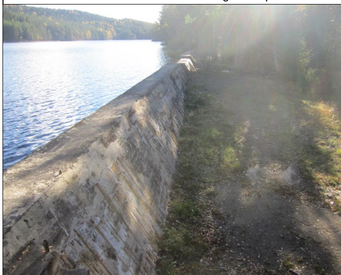
Dammen sett fra lukehus.
