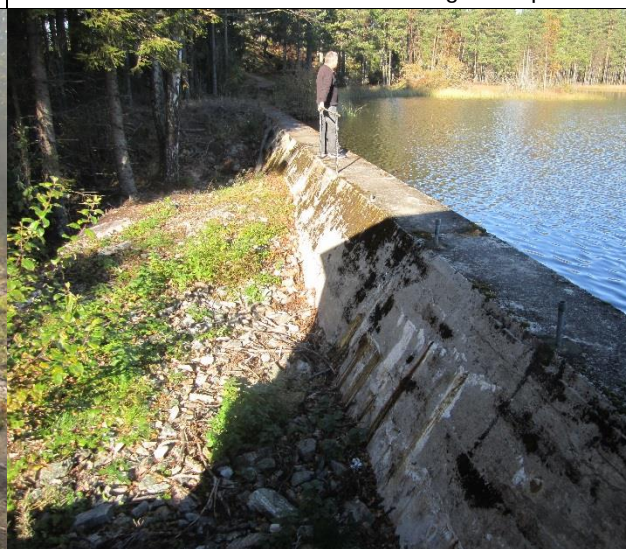
Dam til høyre side for lukehus.
