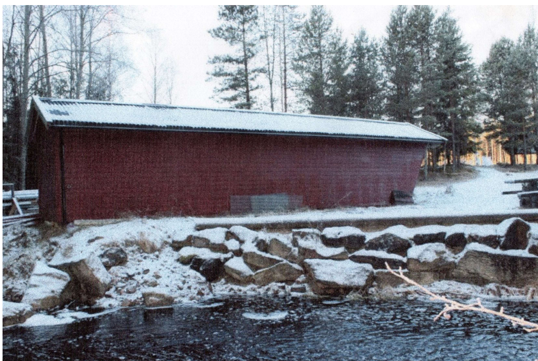
Figur 2 Vannuttaket i Kampåa med pumpehus
