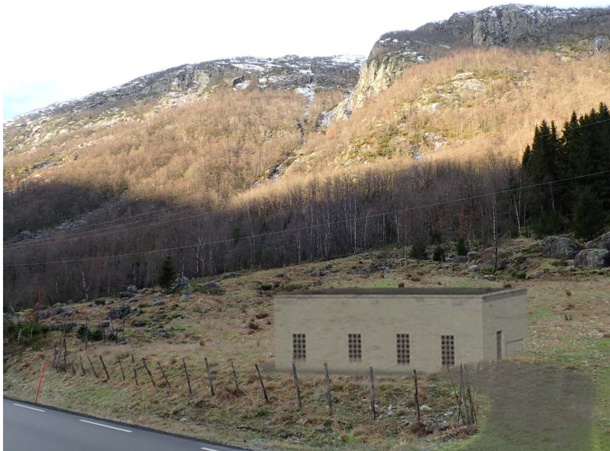
Figur 7.5 Felles kraftstasjonsbygg for Mjelkefossen og Gya kraftverk
