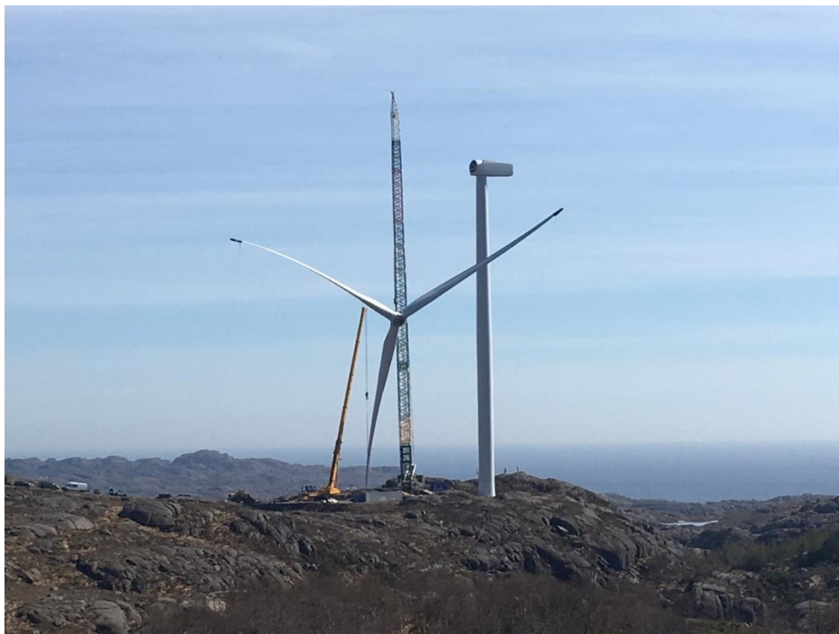
Figur 10 Ved hver turbin etableres det en kranoppstillingsplass som anvendes ved montering av turbinen. Eksempel fra Egersund vindkraftverk. (Foto: Norsk Vind Energi AS)
