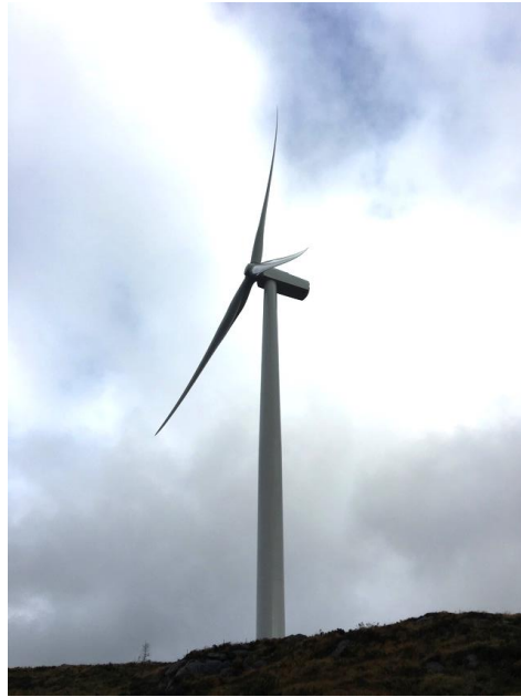
Figur 7 Vindturbin installert i Egersund vindkraftverk i 2017. Navhøyde 93 m, rotordiameter 113 m (Foto: Norsk Vind Energi AS)
