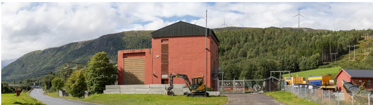
Figur 7: Nytt Svarthammaren vindkraftverk sett fra Krokstadøra transformatorstasjon
