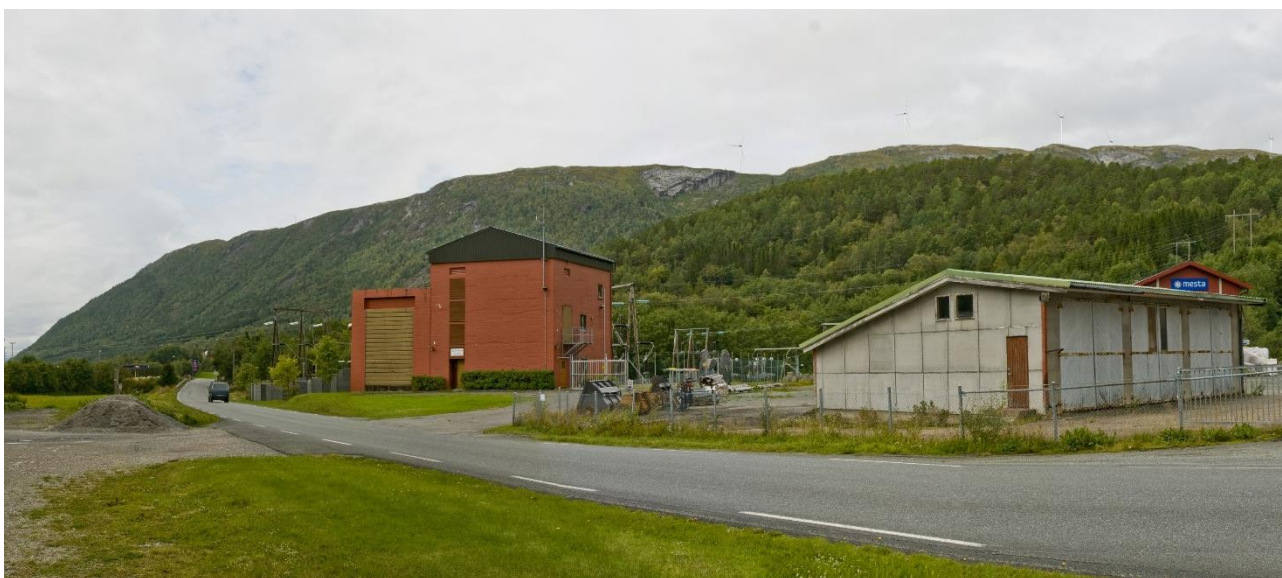
Figur 8: Tidligere konsesjonsgitt vindpark sett fra Krokstadøra transformatorstasjon
