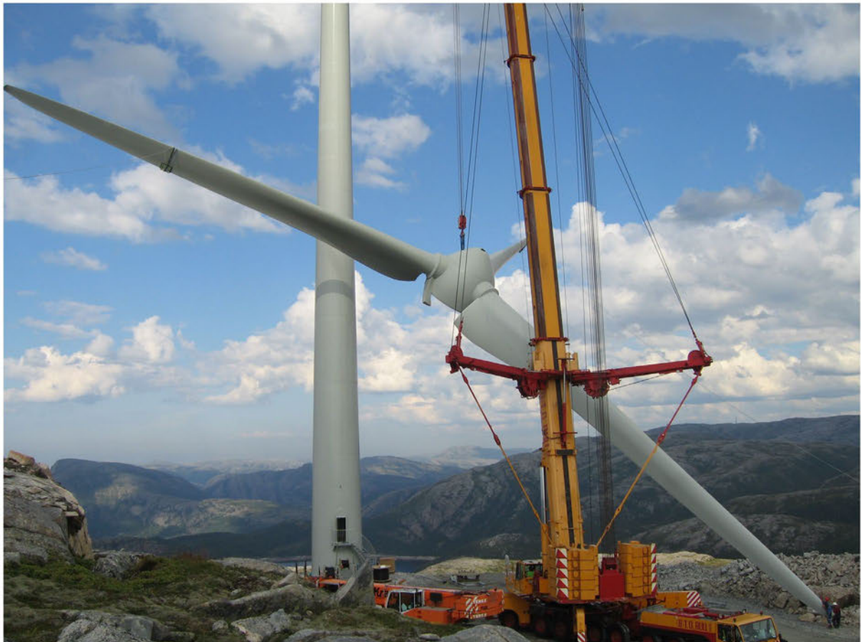
Figur 9. Løfting av nav med vinger (Bessakerfjellet).
