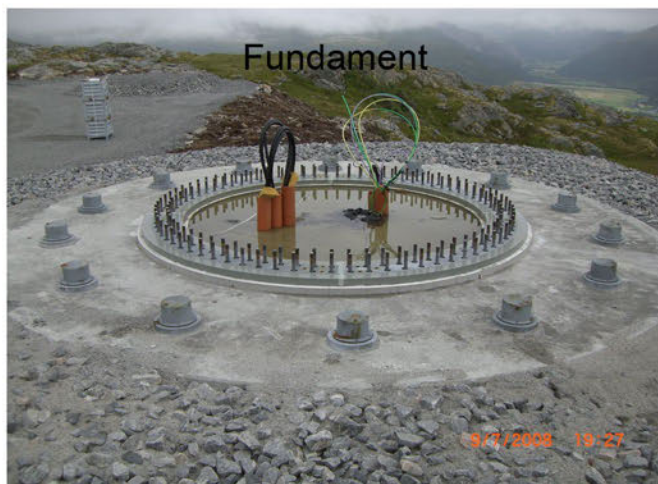
Figur 8. Ferdig støpt og omfylt betongfundament
