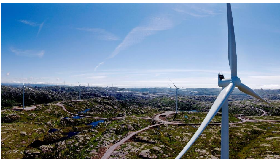
Figur 3 – Bilde fra Tellenes vindkraftverk som viser vindturbiner og veganlegg i et typisk norsk kystnære hei-landskap. Foto: Zephyr/Tellenes Vindpark AS
