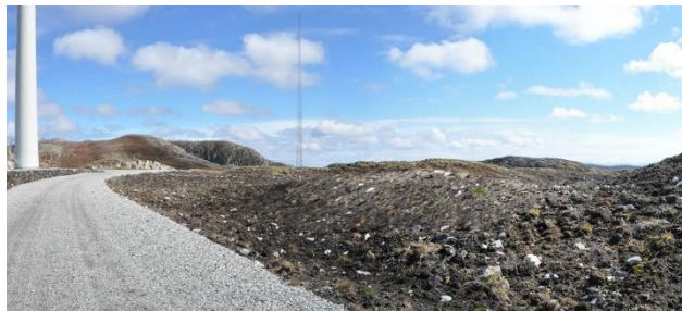
Bilde 8. Det er viktig at arronderte områder ikke blir helt flate, men at de gjenspeiler variasjonene i tiliggende terreng. På bildet til venstre fremstår istandsatt massetak som ei litt for stor og ensarta flate til at den visuelt aksepteres som en naturlig formasjon i det småkuperte terrenget. Eksisterende situasjon Ytre Vikna. Fotomanipulert bilde til høyre viser at en mindre overhøyde på deler av arrondert terreng kan være alt som skal til for et mer naturligt landskapsbilde
