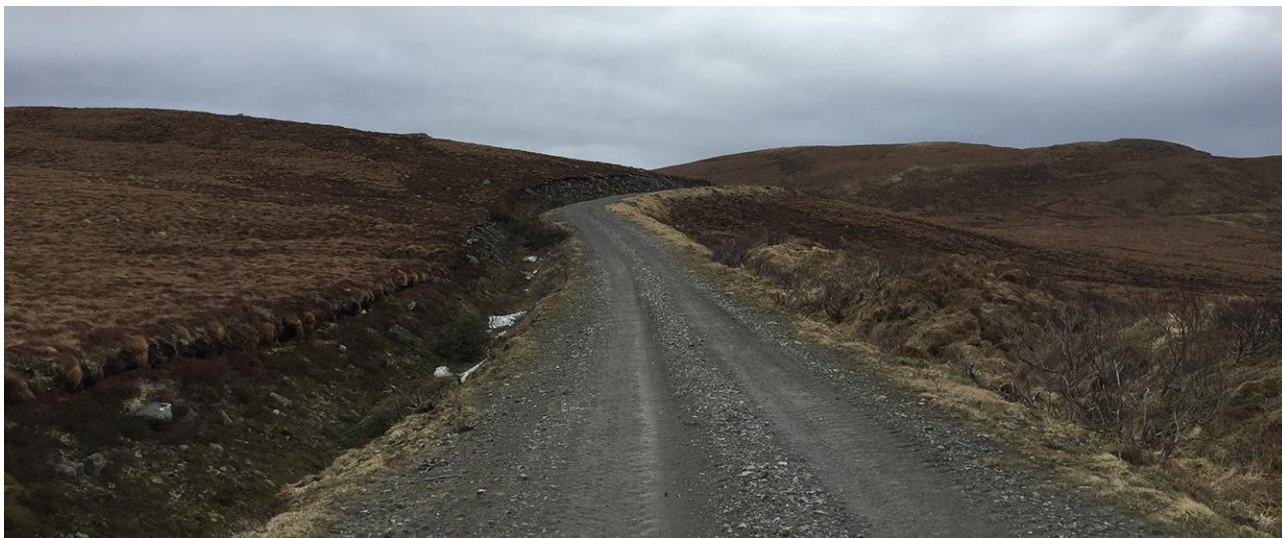
Bilde 6 viser løsmasseskjæring langs eksisterende vei oppe på Haramsfjellet. Disse er ikke bearbeida og overgang mellom vekstlag og undergrunnsjord er markante og gjør skjæringene fremtredende.
