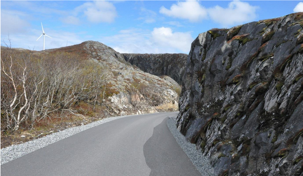
Bilde 15. Manipulert bilde viser en tosidig skjæring der det ikke er gjort tiltak for å dempe den visuelle virkningen av skjæringen til høyre i bildet.
