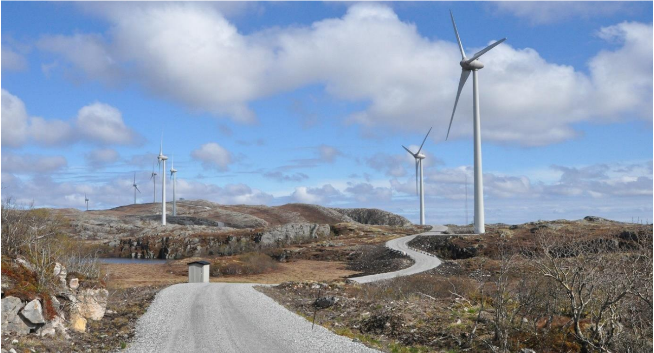
Bilde 12. I det småkuperte landskapet er økt veilengde å foretrekke foran skjæringer. I tillegg kan traseen med fordel legges med litt høyde i terrenget, da fyllinger i prinsippet lettere kan gis en naturlig tilpassing enn skjæringer.
