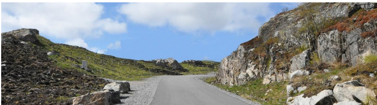
Bilde 22. Ved behov for ekstra masser tas positive former ut i sin helhet. I det manipulerte bildet under er en større gjenstående knaus etter innføring av atkomstvei benyttet, samtidig som man har tatt toppen av skjæringa på motsatt side. Mindre knauser har fått stå igjen for variasjon og en mer naturlig flate.
