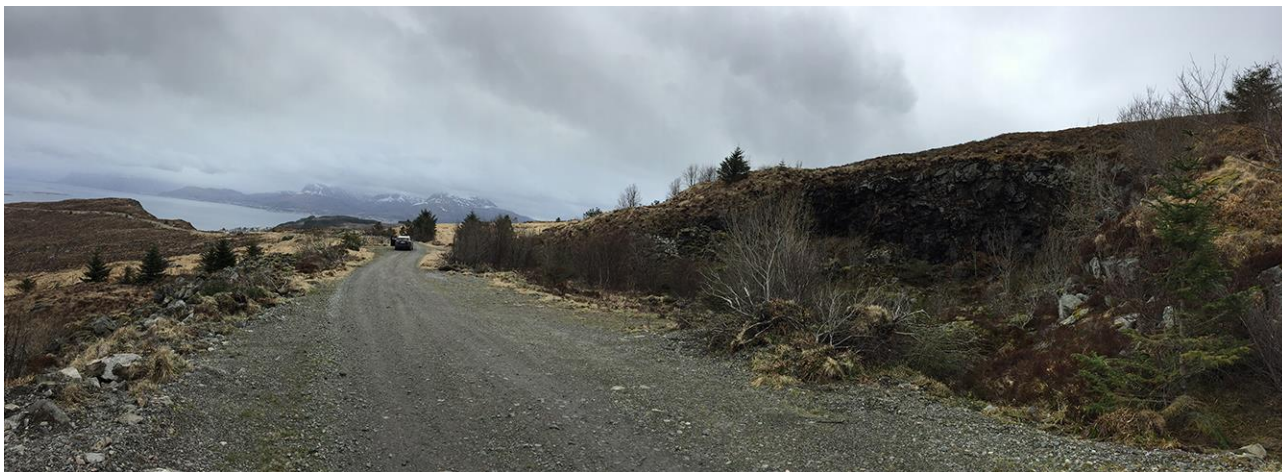
Bilde 23 viser eksisterende masseuttak oppe på Haramsfjellet, benyttet ved bygging av dagens fjellvei. Uttaket står som et åpent sår der tidens tann bidrar til å dempe inntrykket i form av mørkere bruddflate og vegetasjon i forkant. Ved behov for et masseuttak vil det være fint å legge dette til et eksisterende inngrep og man kan samtidig reparere situasjonen ved å legge tilbake vrakmasser og foreta en tilpasset arrondering.
