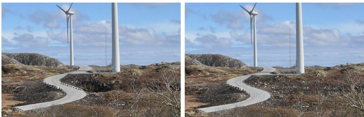
Bilde 10. I det fotomanipulerte eksempelet er det fylt igjen masser i et dalsøkk foran fremre turbin. Inngrepene samles samtidig som veien gis en bedre forankring i landskapet ved å unngå fyllingsskråning på begge sider av veien og kranoppstillingsplass for turbinen blir mindre ruvende. (Manipulert bilde til høyre).
