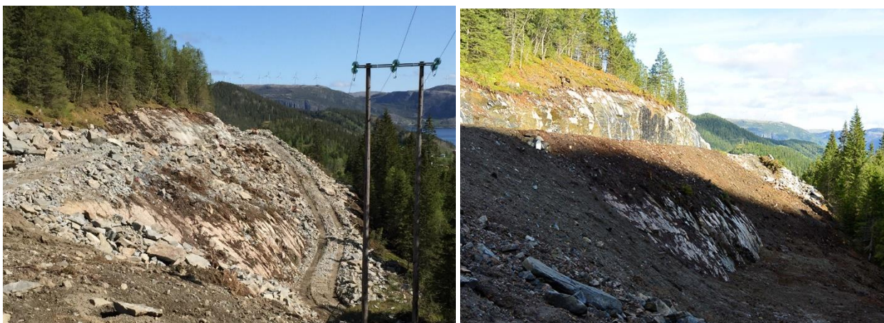
Bilde 4. Under åpning av terrenget kom en fin fjellformasjon fram i dagen. Ved å ta vare på den og tilpasse terrenget inn mot denne unngikk man en utstrakt fylling i dette punktet.
