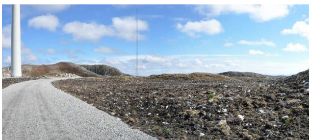
Bilde 8. Det er viktig at arronderte områder ikke blir helt flate, men at de gjenspeiler variasjonene i tiliggende terreng. På bildet til venstre fremstår istandsatt massetak som ei litt for stor og ensarta flate til at den visuelt aksepteres som en naturlig formasjon i det småkuperte terrenget. Eksisterende situasjon Ytre Vikna. Fotomanipulert bilde til høyre viser at en mindre overhøyde på deler av arrondert terreng kan være alt som skal til for et mer naturligt landskapsbilde
