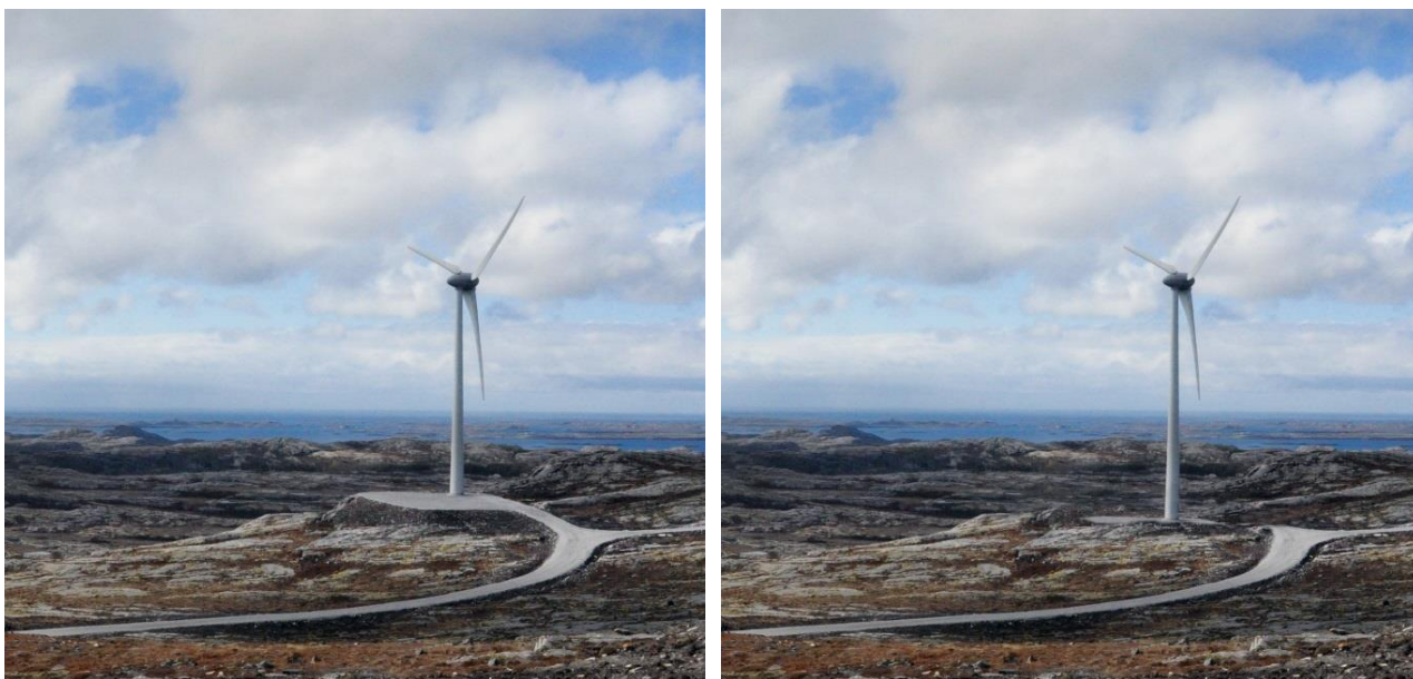
Bilde 21. Minst mulig eksponering av kranoppstillingsplass og fundament er viktig for god landskapstilpassing, her vist ved senking av oppstillingsplass slik at utstrakte fyllinger unngås og gjenstående knauser delvis skjerner for innsyn.
