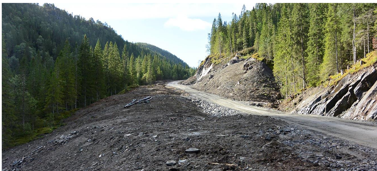
Bilde 14 viser området etter sluttarrondering, Kløfta er fylt opp og skråningene er slakket ut. Veien har fått en god forankring inn mot nytt terreng og virkningen av inngrepet er dempet.
