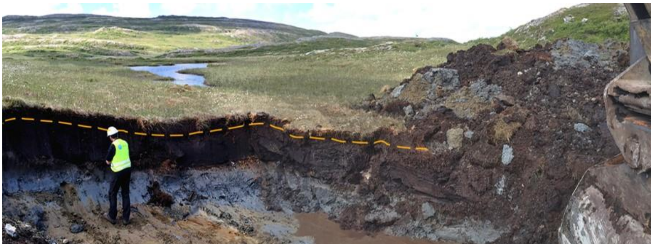
Figur 5. Stipla linje viser nedre grense for det som betraktes som toppjord, der jorda forventes å være en frøbank. I dette tilfellet kan en innblanding av torv fra det neste sjiktet aksepteres, da torva er et godt vekstmedium. Innblanding av den mineralske jorda, som vist til høyre i bildet, skal ikke forekomme.
