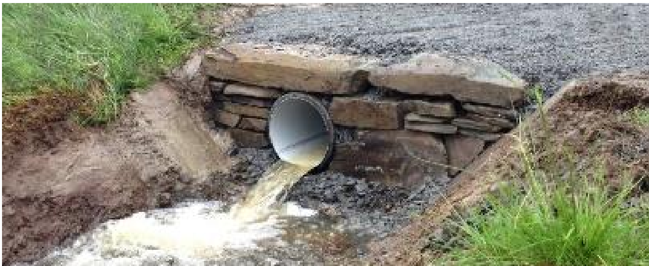
Bilde 20 viser en god bearbeiding inn mot stikkrenna. Grad av opparbeiding må tilpasses sted og eksponering.
