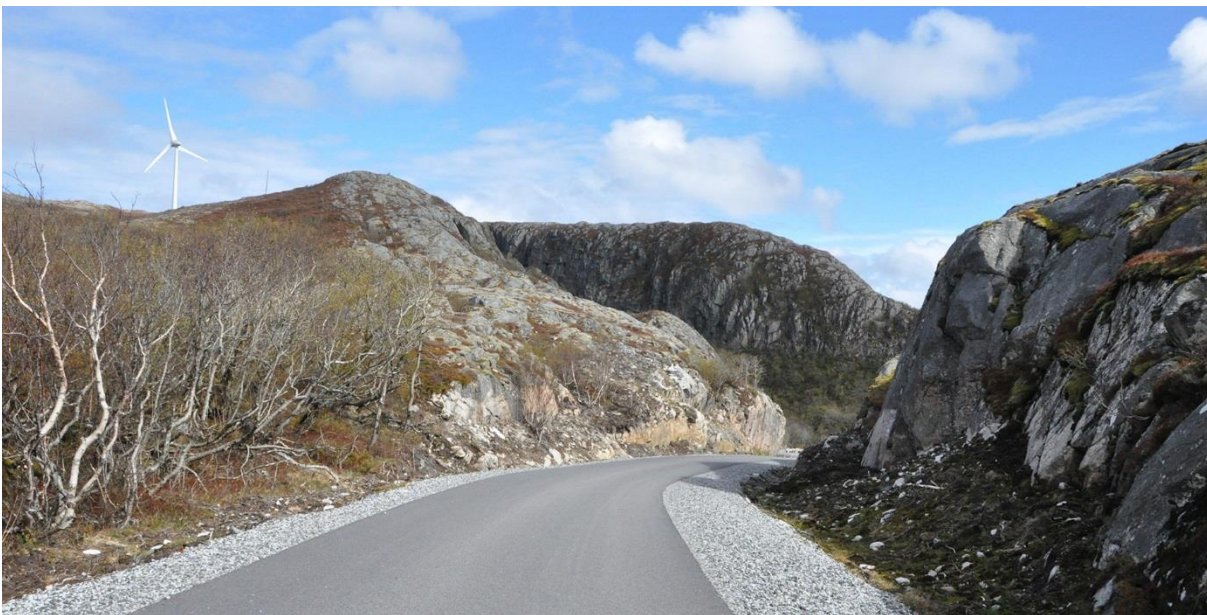
Bilde 16. Dersom veien må føres gjennom fjellparti og tosidige skjæringer ikke kan unngås, er det viktig at det settes av nok plass til at tverrsnittet føles romslig og skjæringene kan bearbeides i bunn og topp for å minske deres visuelle høyde og myke opp profilet. (Originalbilde fra asfaltert adkomstvei til vindkraftverket på Ytre Vikna)
