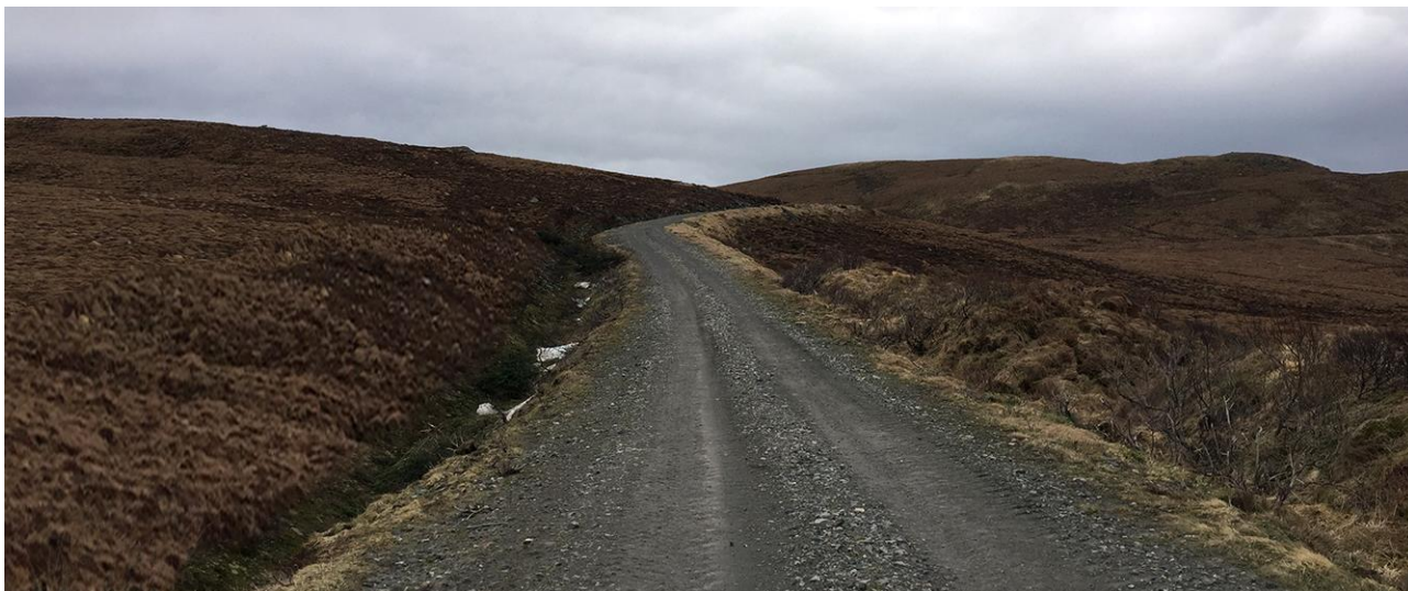
Bilde 7 er manipulert for å vise hvordan inngrepets inntryksstyrke kan reduseres ved å ta ned skjæringshellingen og dra vegetasjonen ned til veibanen.
