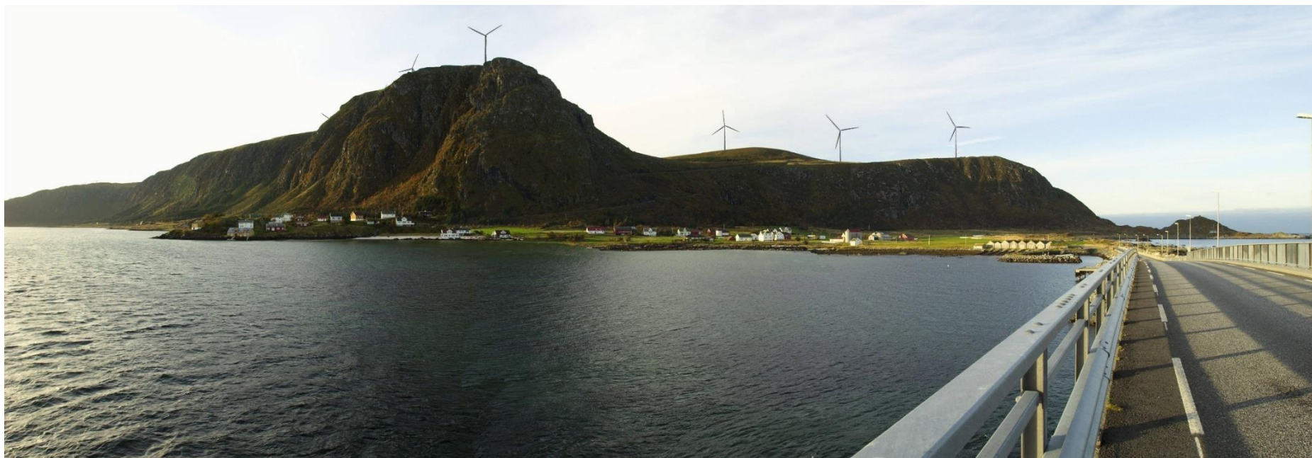
Visualisering fra Ullasundet, 8 turbiner med 90 m navhøyde og 136 m rotordiameter. Turbinplassering avviker noe fra endelig løsning, som har 82 m navhøyde.
