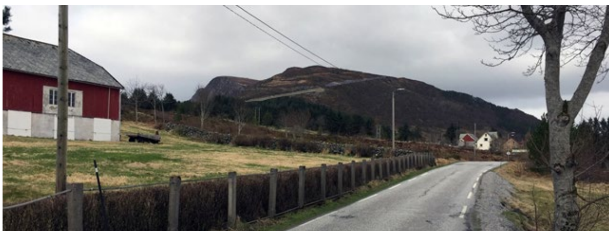
Figur 8 viser ny vegtrase opp i fjellsida slik det antas å se ut i det anlegget ferdigstilles, før vegetasjon er reetablert og vegskjæringene er på sitt lyseste (utarbeidet ved bruk av modell importert og bearbeidet på bilde.)
