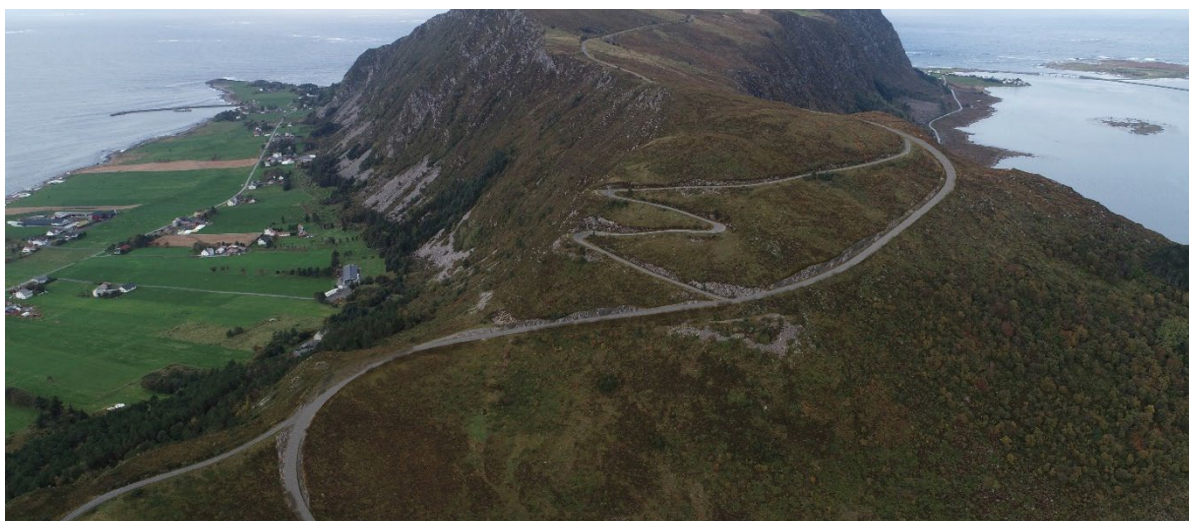
Figur 7 viser et oversiktlig modellbilde av nytt vegstrekk sett fra sør med henholdsvis anleggsfase i midten, der sammenhengende grå flater fra fyllingsfot til skjæringstopp vil gjøre vegstrekket markant i landskapsbildet. Det mest iøynefallende vil være den høye fyllingen ved første hårnålssving. Etter revegetering, nederst, og når fargen veg og fjellskjeringer blir mørkere vil inngrepet fremstå som mer dempa og ikke spesielt mer markant enn ved dagens situasjon siden inngrepet ved første hårnålssving vil fremstå som redusert. Sett herfra, i fugleperspektiv, er de synlige vegbanene med på å forsterke inntrykket av ny vegføring.
