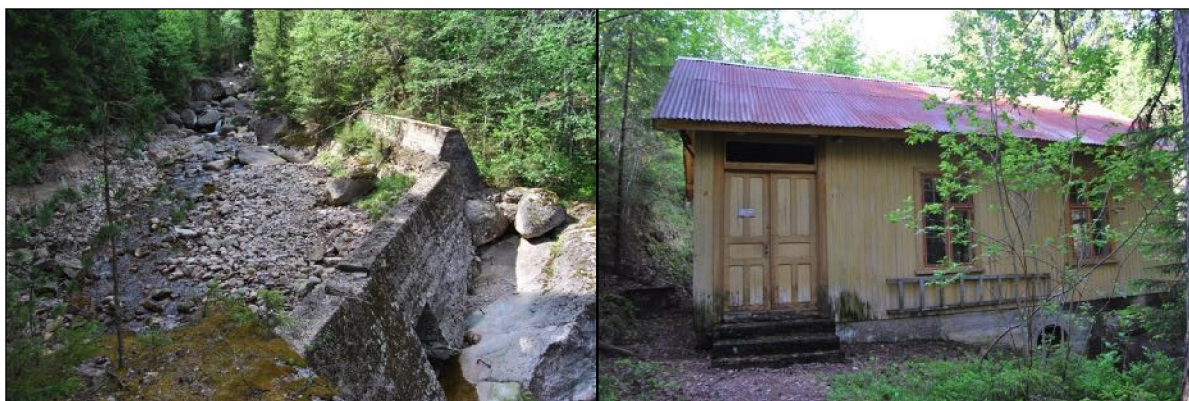
Figur 8. Restar av tidlegare kraftanlegg i Kvennåi: inntak og kraftstasjon.
