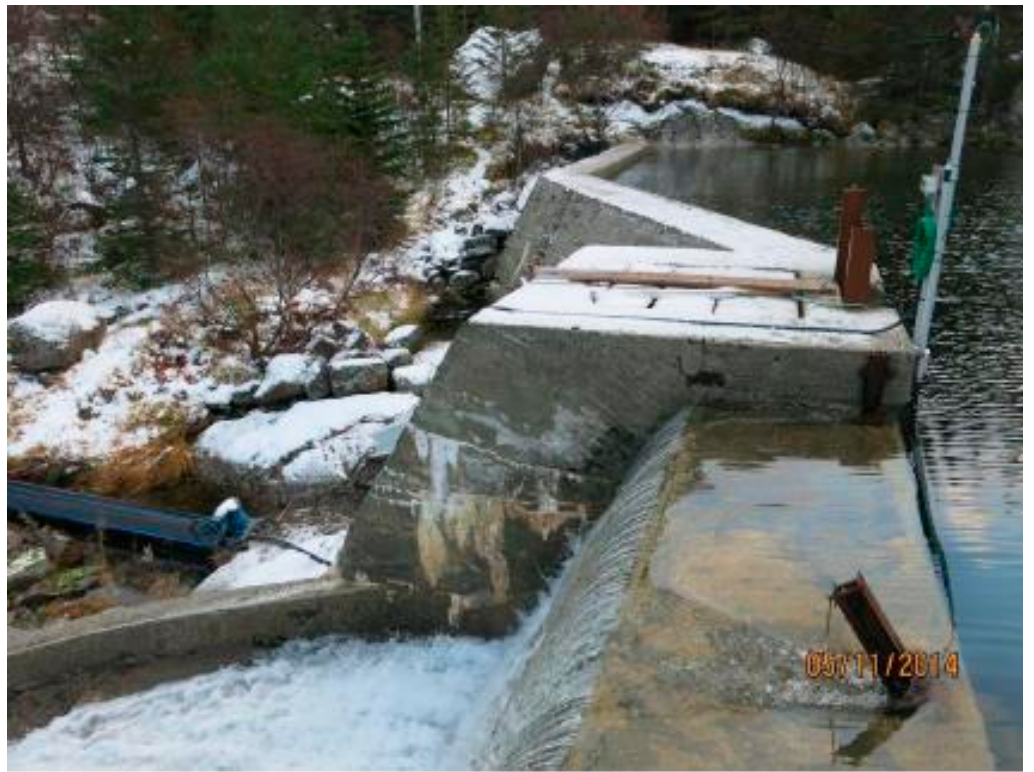
Overløp, inntakskonstruksjon og damtopp mot sør
