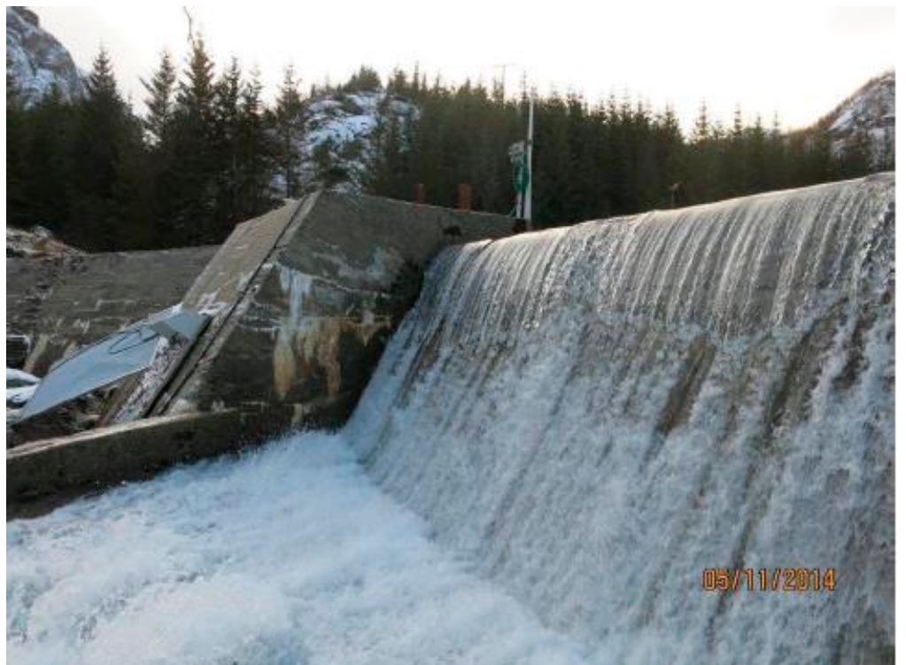
Overløp og damtopp mot nord
