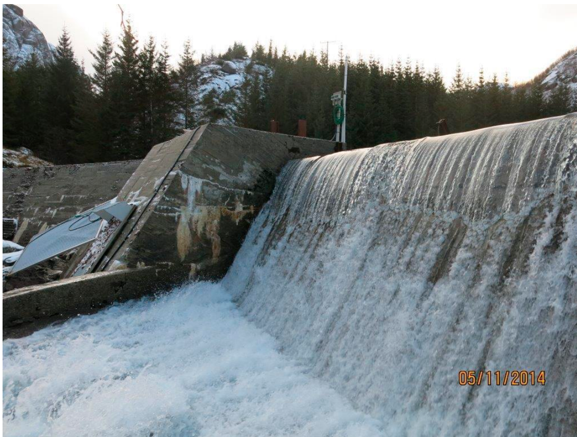
Flomløpet på dam Storvatnet, fritt overløp uten pilarer
