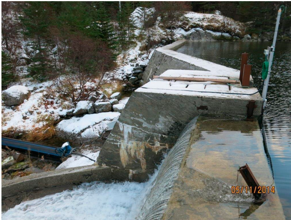
Foto 1: Overløp, inntakskonstruksjon og damtopp mot sør
