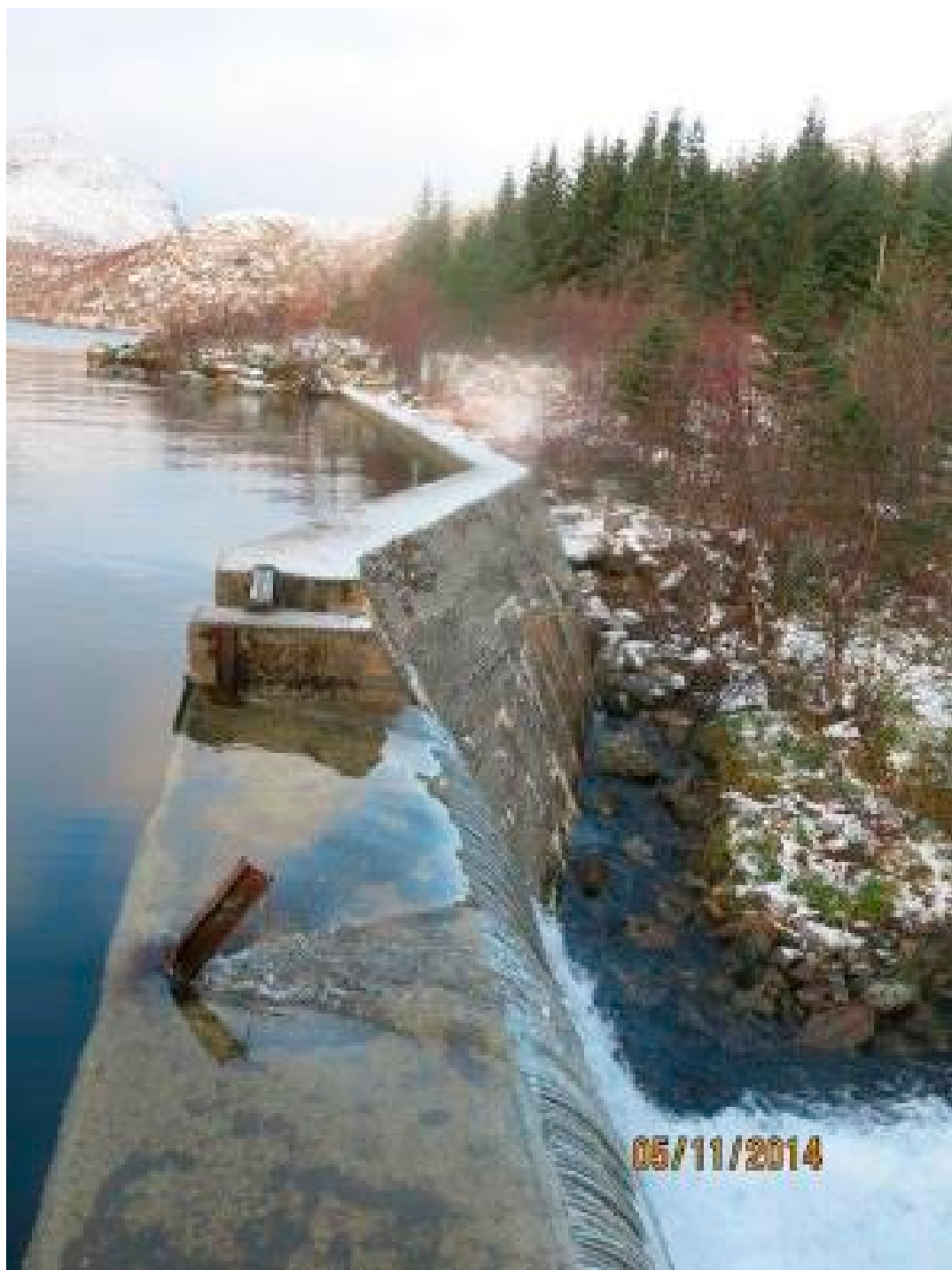
Flomløpet på dam
