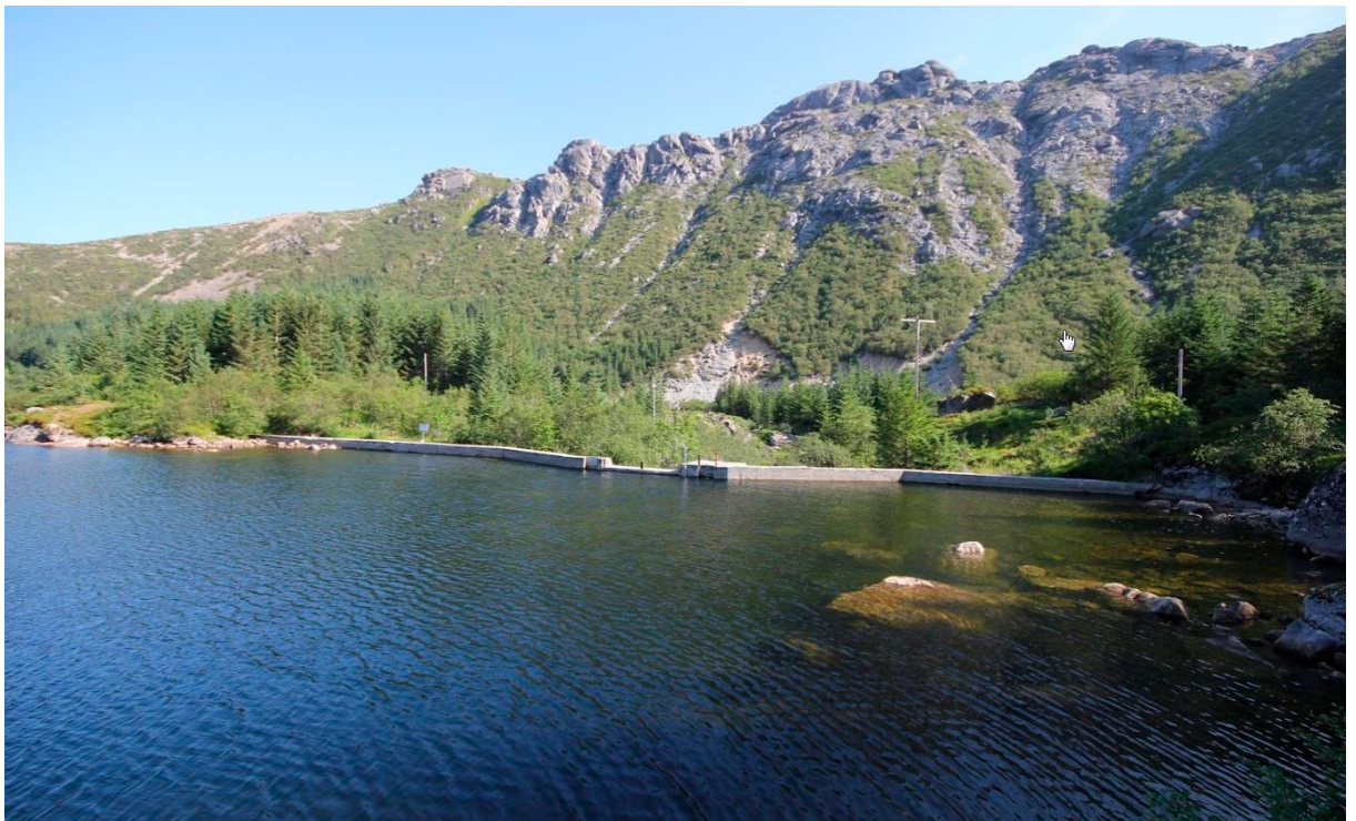
Oversiktsbilde fra oversiden
