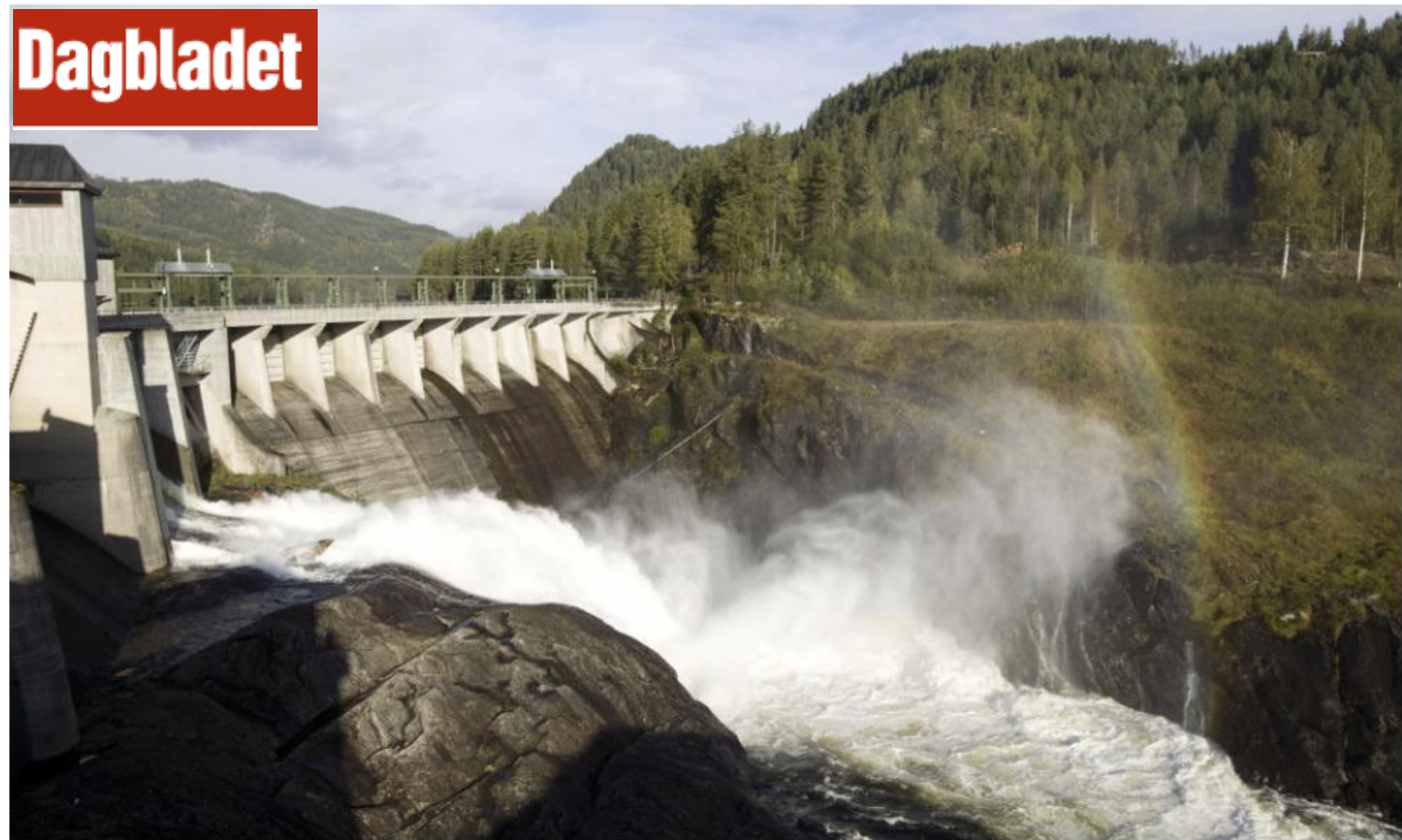
STRØM: Strømprisen er historisk høy. Årsaken er lite nedbør. Her er Grønvollfoss kraftverk ved Tinnelva i Notodden, tatt i 2011. Foto: Terje Bendiksby / Scanpix
