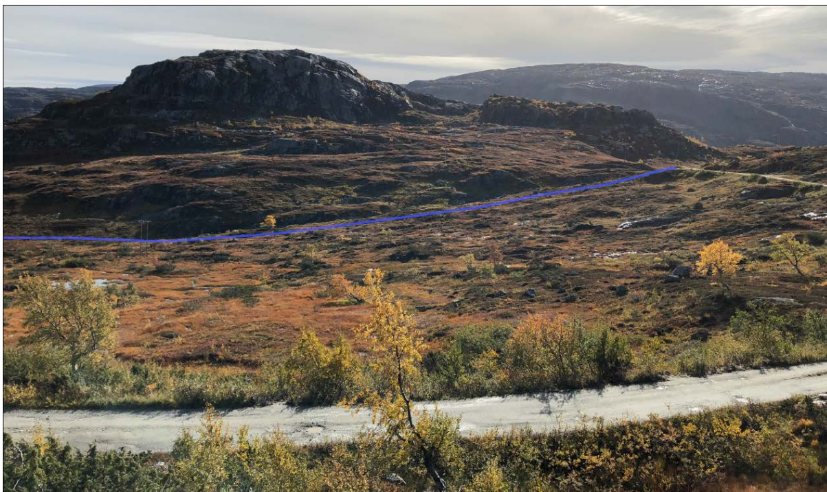
Figur 4. Foto fra Gamle Haukeliveg mot sørvest. Omtrentlig trase for ny anleggsveg i blå farge. Statkrafts anleggsveg.
