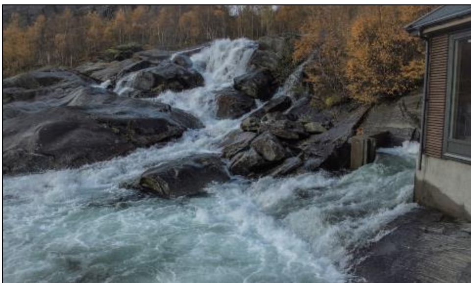
Figur 3. Strømdalselva med inntaket til Kistafossen kraftverk ( øverst ), med øvre del av kraftverkets rørgate ved kryssing under RV17 ( midten ) og Kistafossen og med Kistafossen kraftverk og utløpet derfra ( nederst ).
