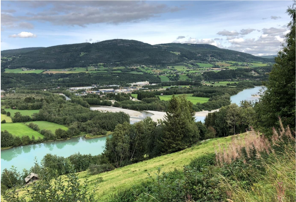
Eksisterende 66 kV krysser utløpet av Frya. Frya bidrar med mye massetransport og ustabile grunnforhold nær elvas utløp i Lågen.
