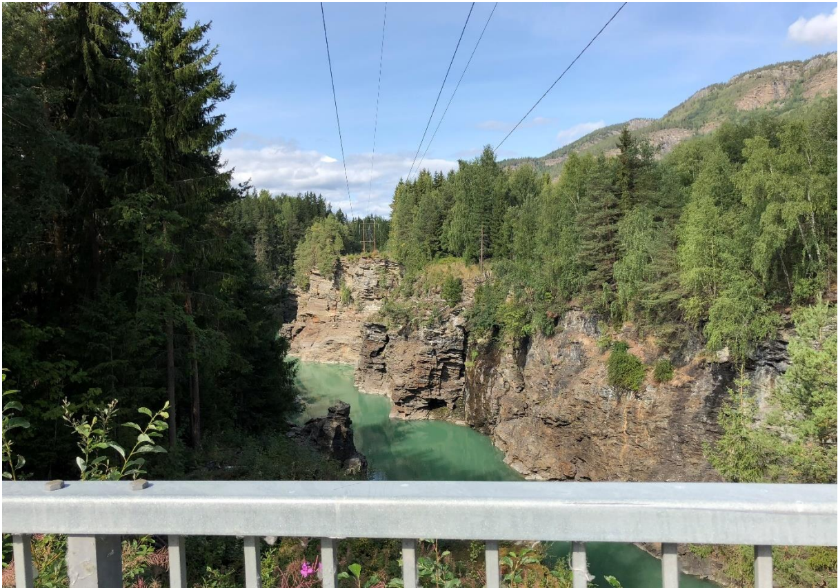
Eksisterende ledning krysser bekkekløfta/juven ved Harpefossen flere ganger.
