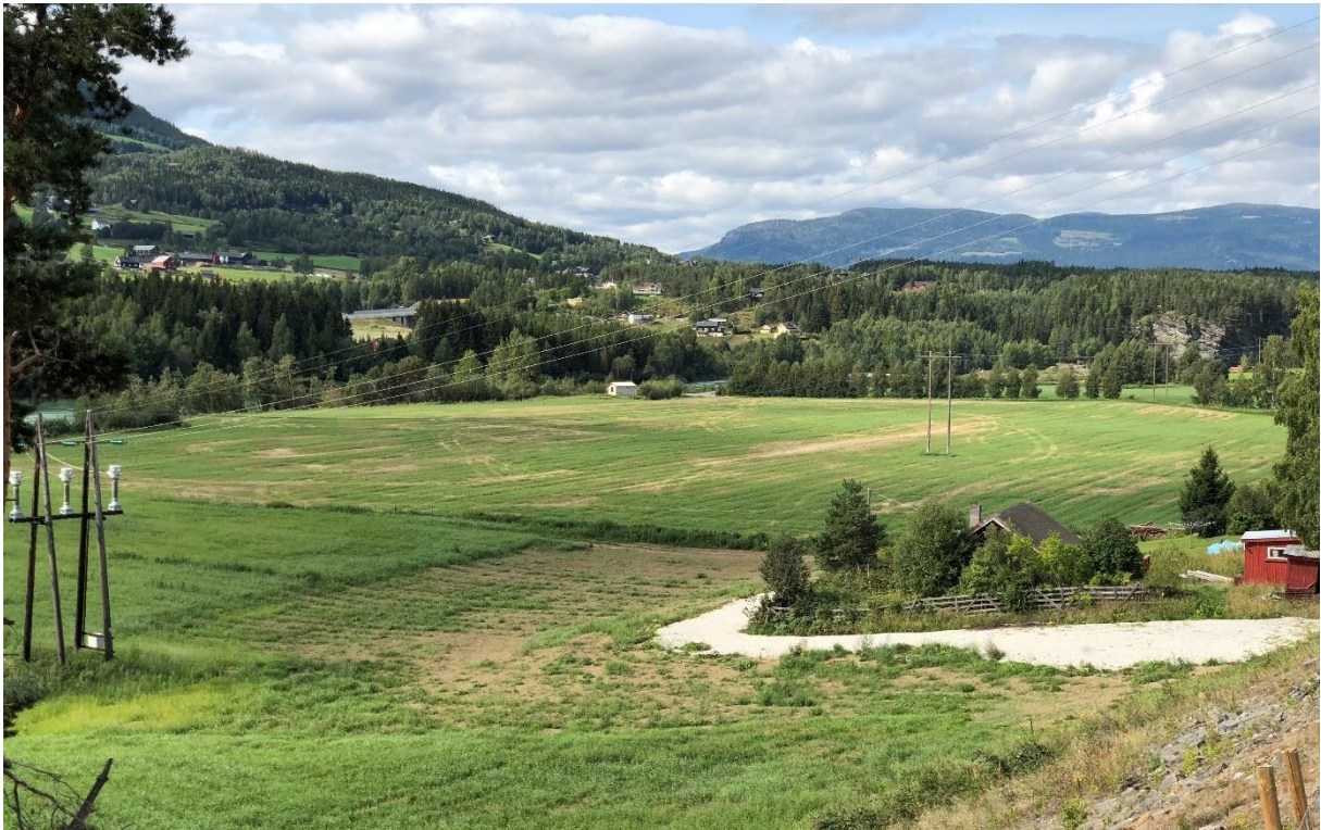
NSBs endemast og linje til omformerstasjonen. Eksisterende 66 kV linje kommer inn fra høyre bildekant og går rett over jordene.
