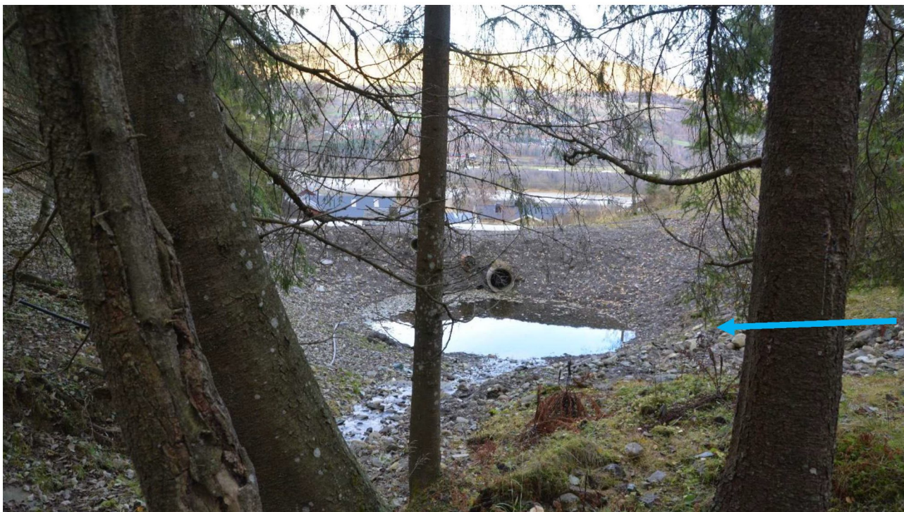
Figur 19. Bekk lagt i rør under skogsvei. Ca. diameter på rør 400 mm. Blå pil viser trolig flomløp fra sørøstlig retning.
