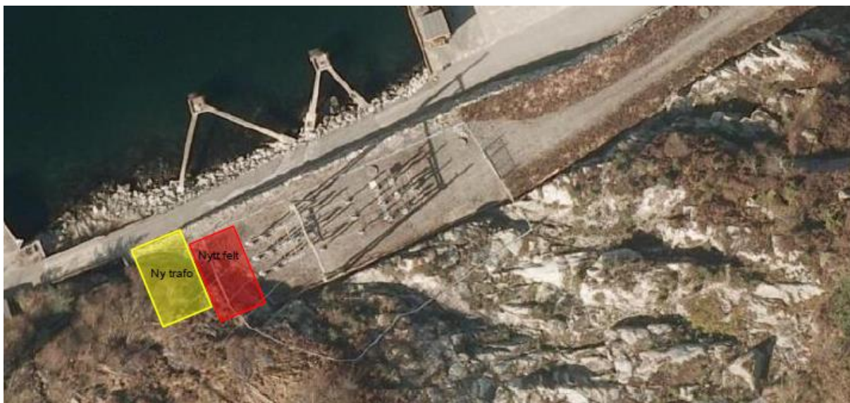
Figur 6 Utvidelse av 132 kV koblingsanlegg på Flørli
