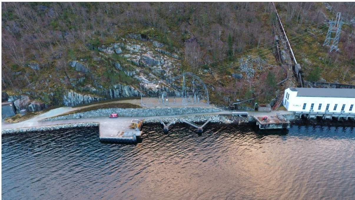
Figur 3 Lyse Produksjon AS sitt 132 kV koblingsanlegg på Flørli
