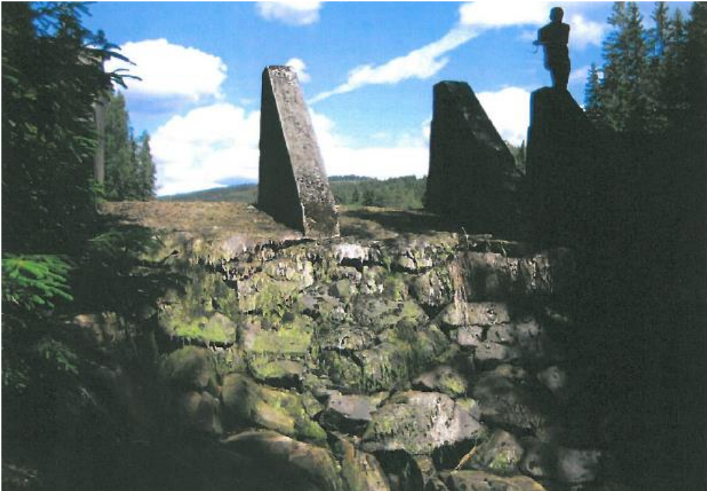
Figur 3: Flomløp sett fra nedstrøms side 1. juni 2013. Dammen ble revet til og med pilar lengst til høyre i bildet.
