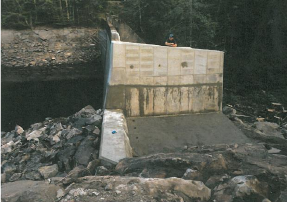
Figur 5: Flomløp etter tiltak, med rør for avlastning av eventuelt poretrykk nedstrøms terskel. Skrånende steinfylling på oppstrøms side av overløpstærskel er også på plass, for å avlaste mot istrykk.
