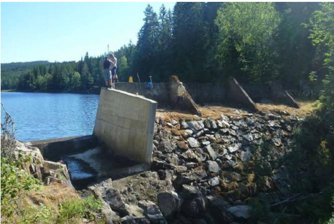
Figur 6: Dagens overløp ved dam Nord-Fløyta sett fra nedstrøms side.
