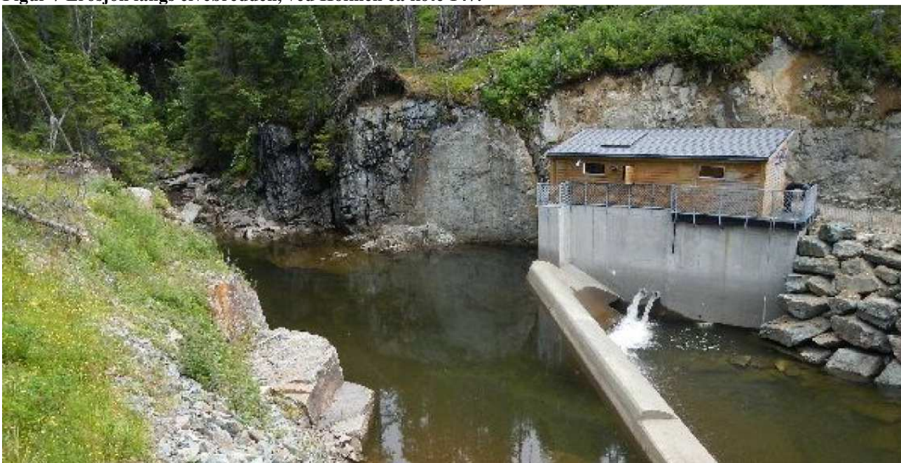
Figur 8 Inntaket til Bruvollelva kraftverk.
