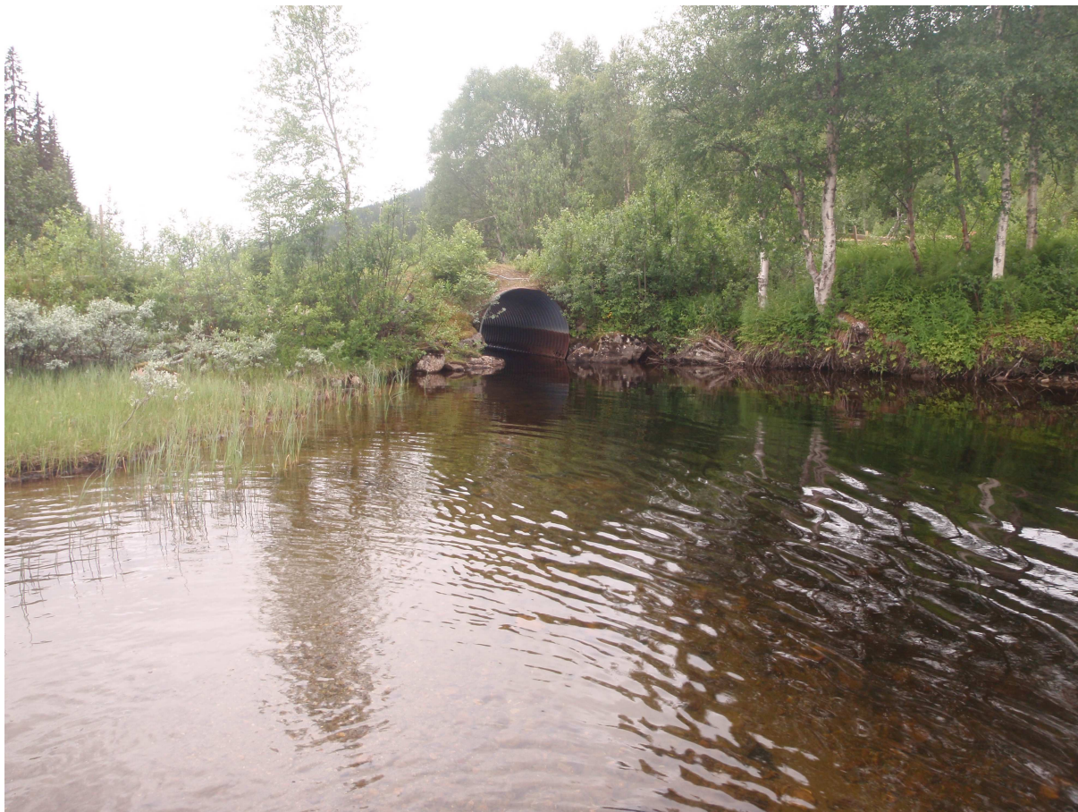
Figur 1 Damsted i utløpet av Trollsvatnet. Bildet viser også kulvert-rør under Trollsvassvegen.
