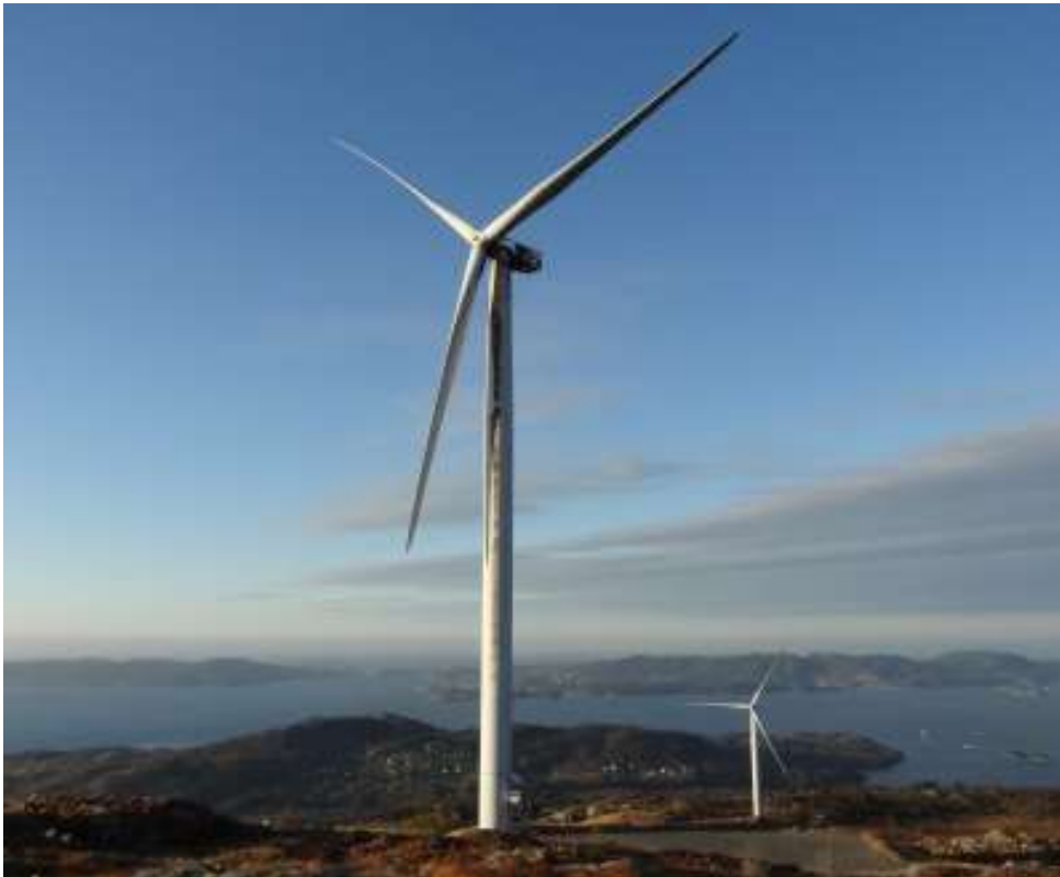
Figur 6: I 2015 ble én vindturbin i Midtfjellet vindkraftverk skadet da det begynte å brenne i vindturbinen. Foto: Midtfjellet Vindkraftverk AS.
