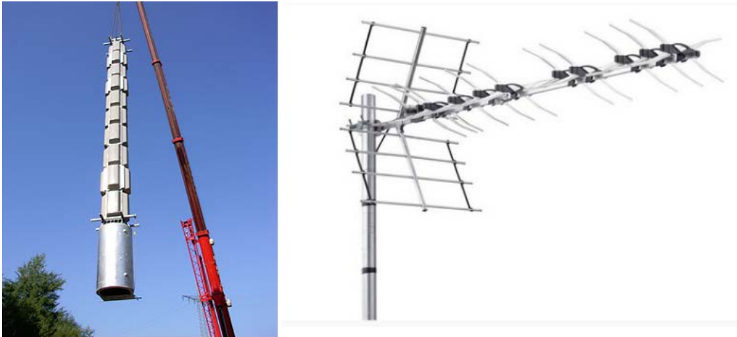
Bilde 2: Montering av en rundtstrålende DVB-T senderantenne (til venstre) og en typisk direktiv mottakerantenne for DVB-T (til høyre) (Kilder: http://www.kathrein.de/content/index.cfm/presse.view?id=1123&language=en og https://www.rikstv.no/produkter/utstyr/stor-antenne/ nedlastet: 27.02.2018).
