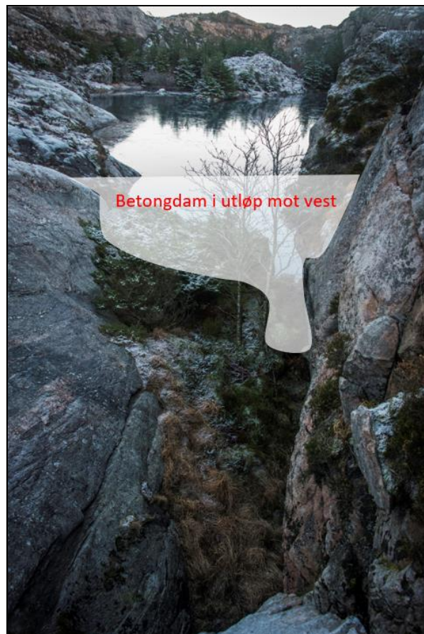
Figur 8. Utløpet er trangt og planlagt betongdam vil ikke være mange meter bred.
