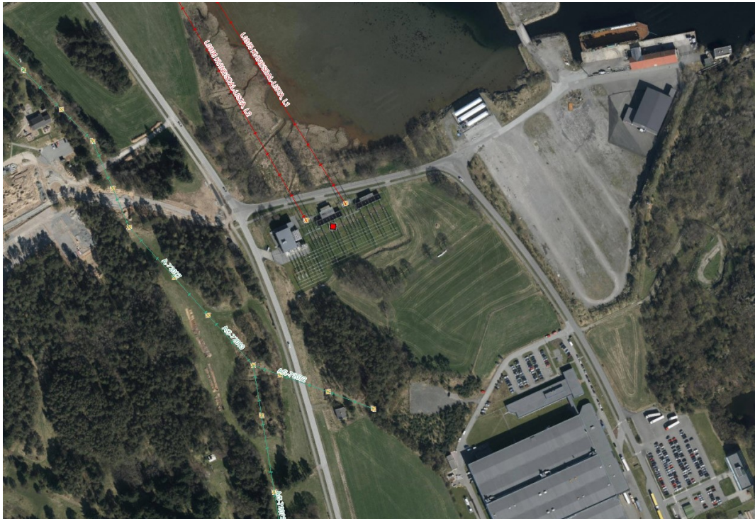
Figur 10: Flyfoto av området rundt transformatorstasjonen ved Alcoa. Kilde: NVE Atlas
