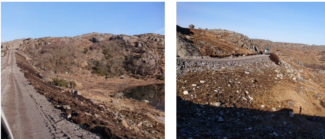
Figur 16 - Istandsetting av fyllingsskråning med stedegne masser, Bjerkreim vindkraftverk
