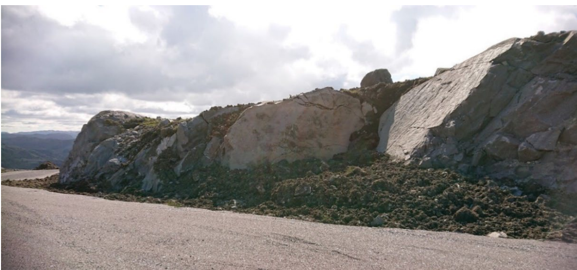
Figur 17 - Fjellskaering delvis kledd med løsmasser, Bjerkreim vindkraftverk
