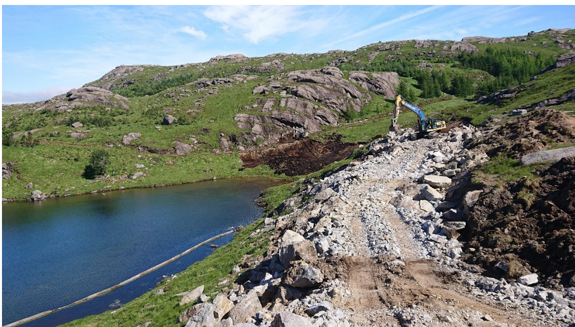
Figur 11 - Eksempel på forebyggende tiltak innenfor nedslagsfelt, Bjerkreim vindkraftverk
