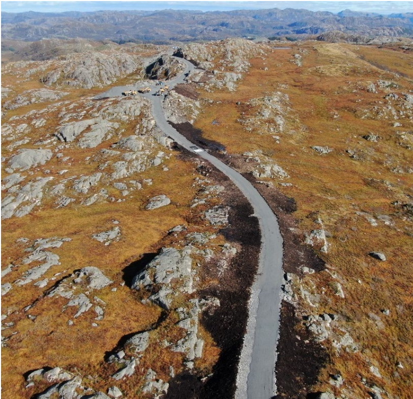
Figur 14 - Nybygd veg i Måkaknuten vindkraftverk
