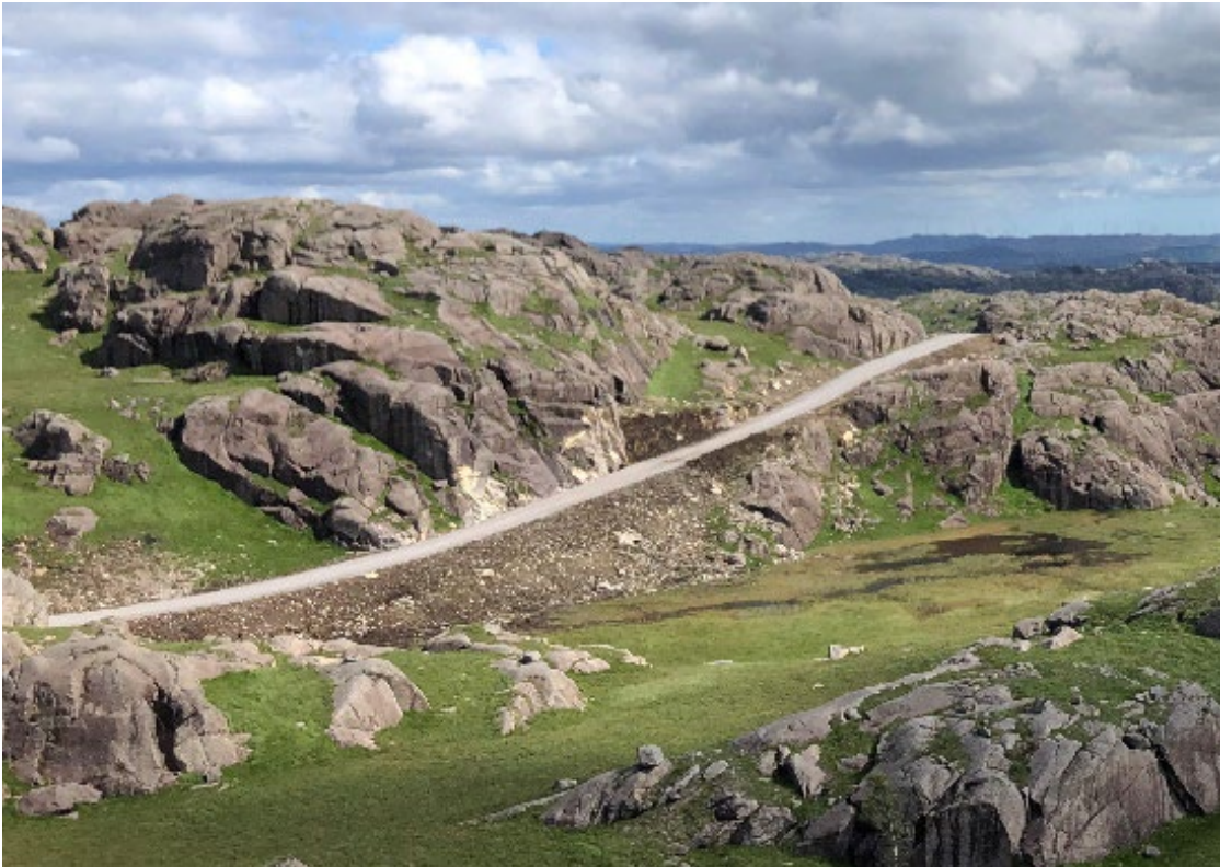
Figur 8 - Eksempel på god forankring mot eksisterende terreng fra Bjerkreim vindkraftverk
