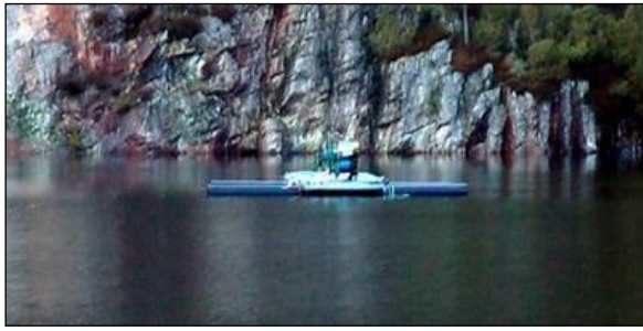
Figur 3. Settefiskanlegget har to vanninntak i Skålavatn ( øverst til venstre ) som kan senkes ned mellom 1 og 20 m dyp. Vannet ledes inn i et blandedebasseng hvor vannet tilsettes kalk og silikat ( øverst til høyre ) før vannet føres i ledning langs Lønnebekken ned til anlegget ( nederst ) (fra Johnsen & Tveranger 2008).
