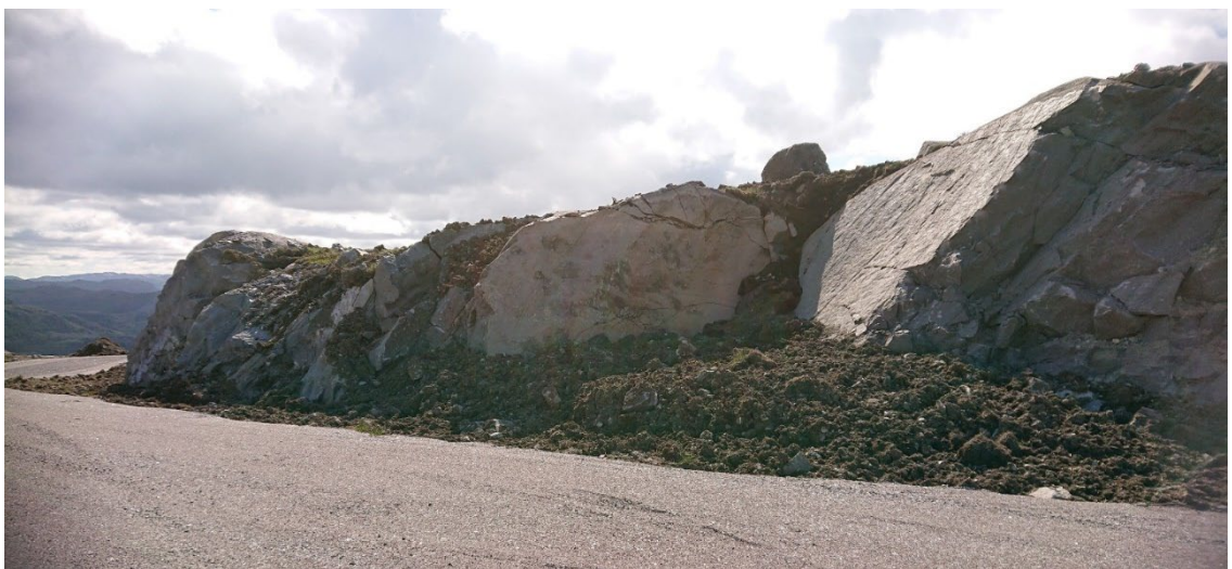
Figur 20 - Fjellskjæring delvis kledd med løsmasser.
