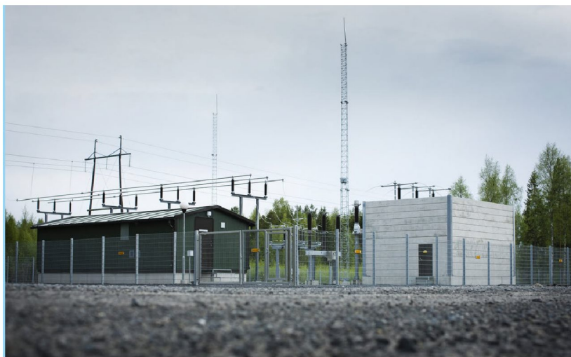
Figur 22 - Eksempelbilde, kontrollbygg, transformatorstasjon og koblingsanlegg (Kilde: VEO AS)
