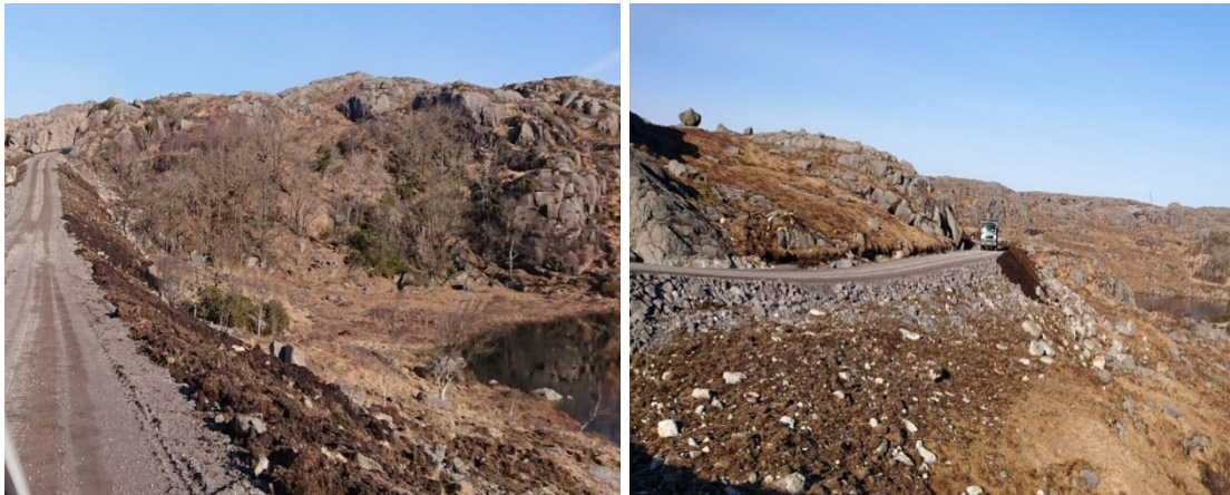
Figur 19 - Istandsetting av fyllingsskråning med stedegne masser
