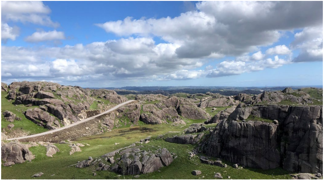
Figur 14 - Eksempel på god forankring mot eksisterende terreng. En stor fylling begrenser behovet for skjæringer som i dette tilfellet ville gitt større inngrep i landskapet.
