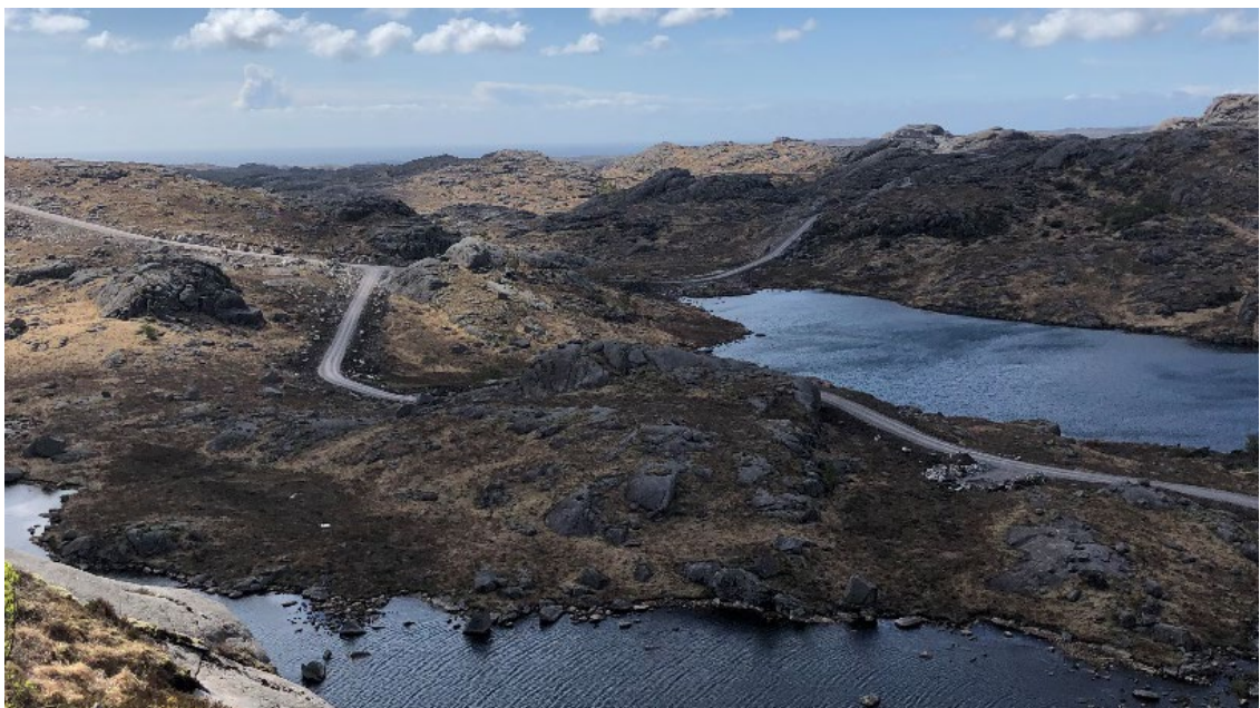
Figur 15 - Bruk av terreng for kamuflering av veinett fra Bjerkreim vindkraftverk. Lange rettstrekk på veien bør begrenses da de bryter med terrengets organiske former.
