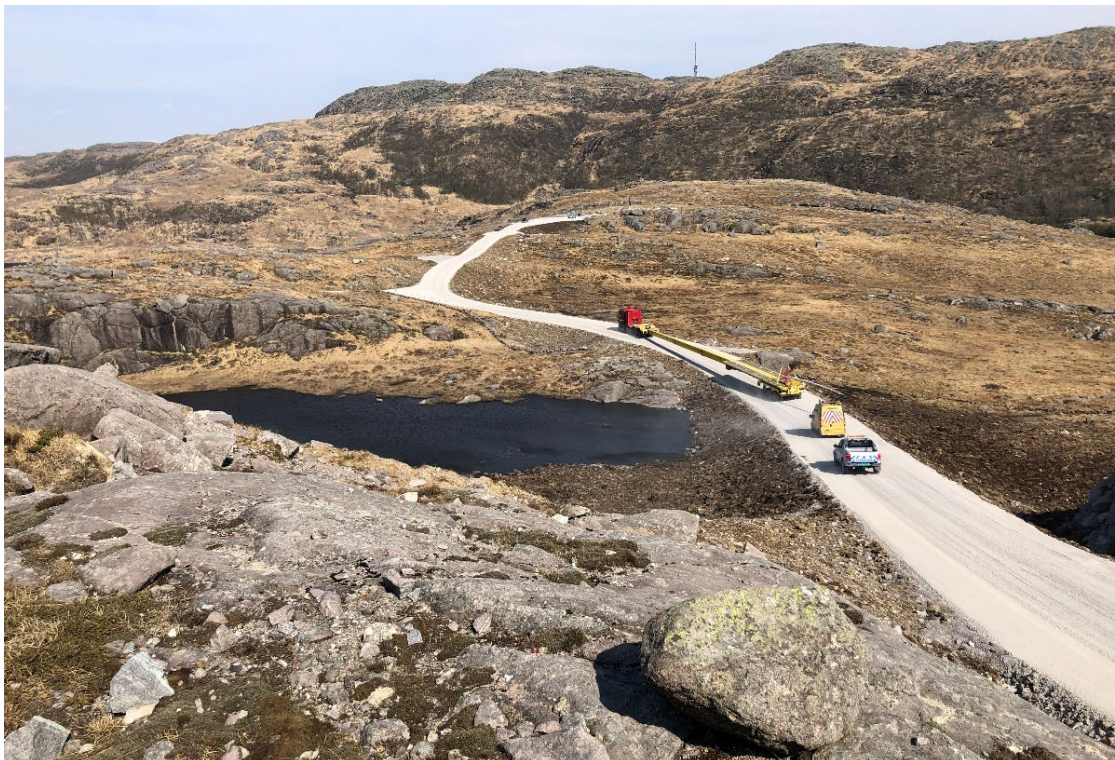
Figur 17 – Tilpasset bruk av toppmasser etter variasjoner i terreng og tilstøtende overflater, Bjerkreim vindkraftverk
