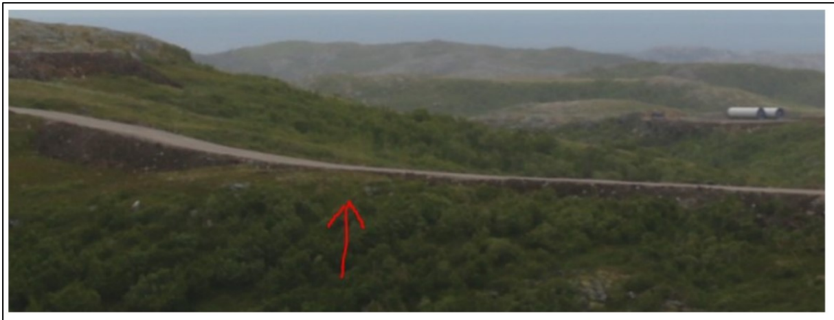
Figur 14: Eksempel på vei som er bygget på fylling, men hvor det eksisterende terrenget bryter fyllingen. På denne måten blir veien bedre tilpasset landskapet og veien blir ikke så synlig på avstand. Foto: NVE.
