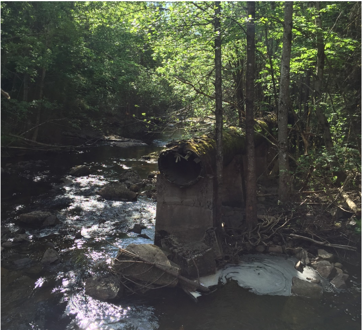
Figur 6 Rester av rørgate som ble brukt i forbindelse med det nedlagte vannkraftverket
