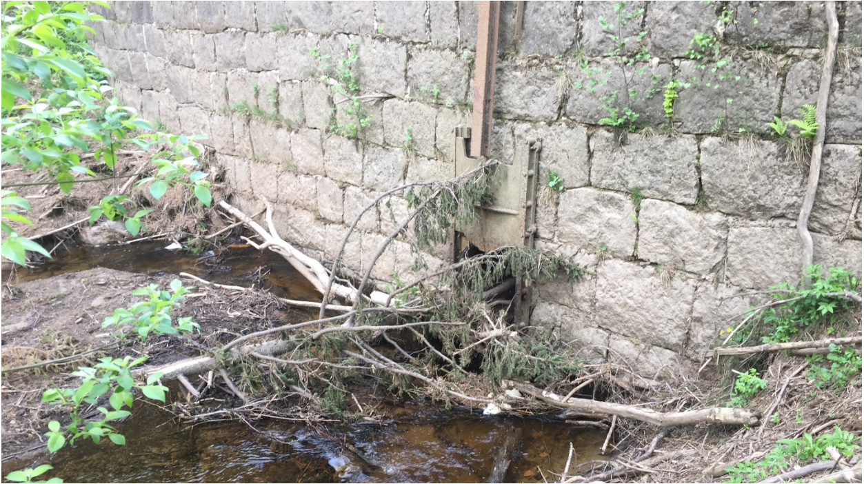
Figur 4 Mølledammen med bunntappeløp sett fra vannsiden
