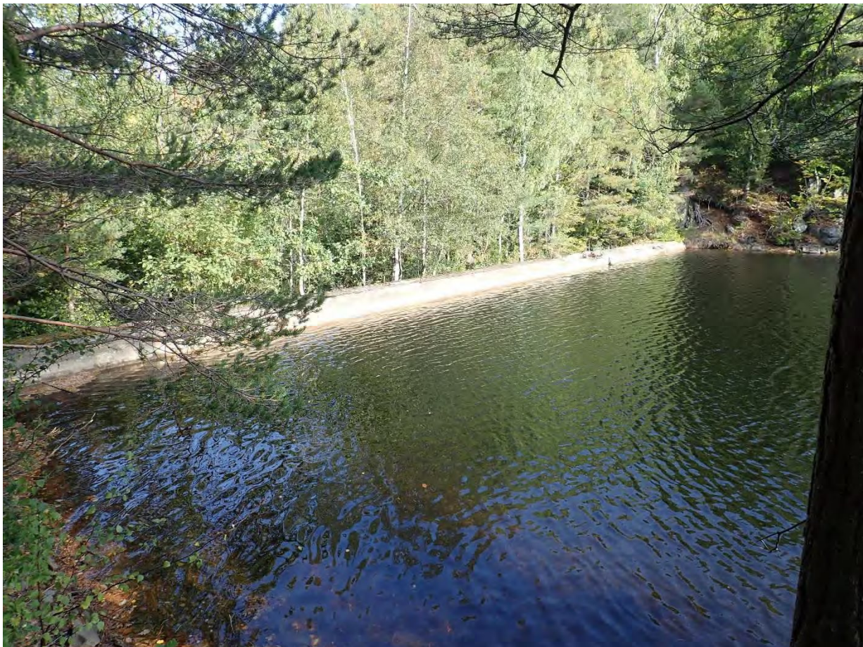
Figur 2. Dammen sett fra venstre landfeste.
