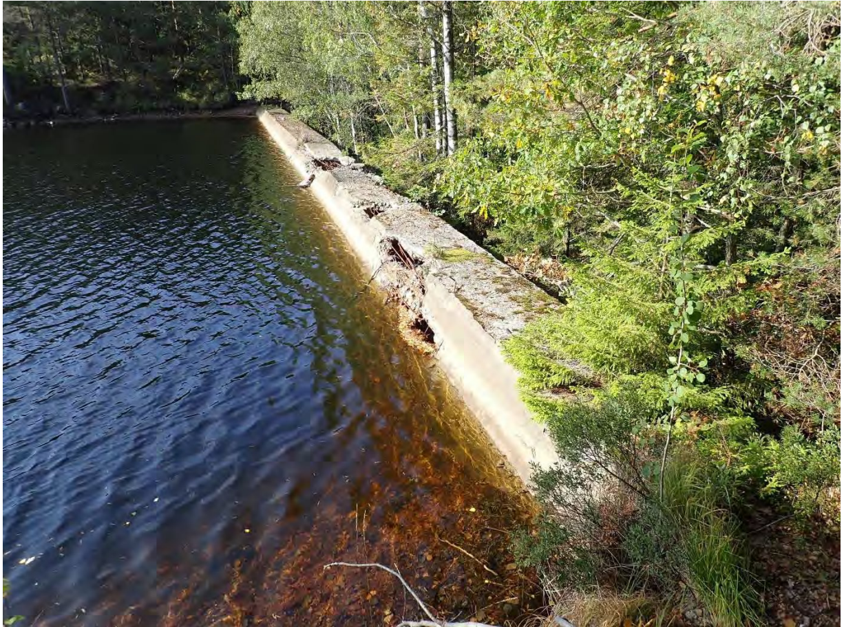
Figur 1. Dammen sett fra høyre landfeste.
