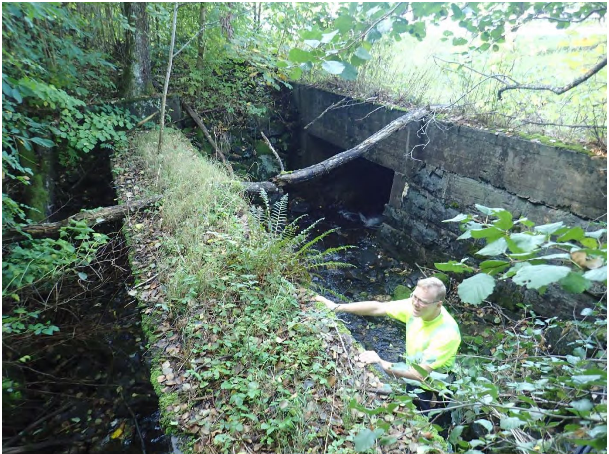
Figur 28. Gartebekken krysser under FV416. Merk: rørbro for vannforsyning til Risør oppstrøms kulvert.
