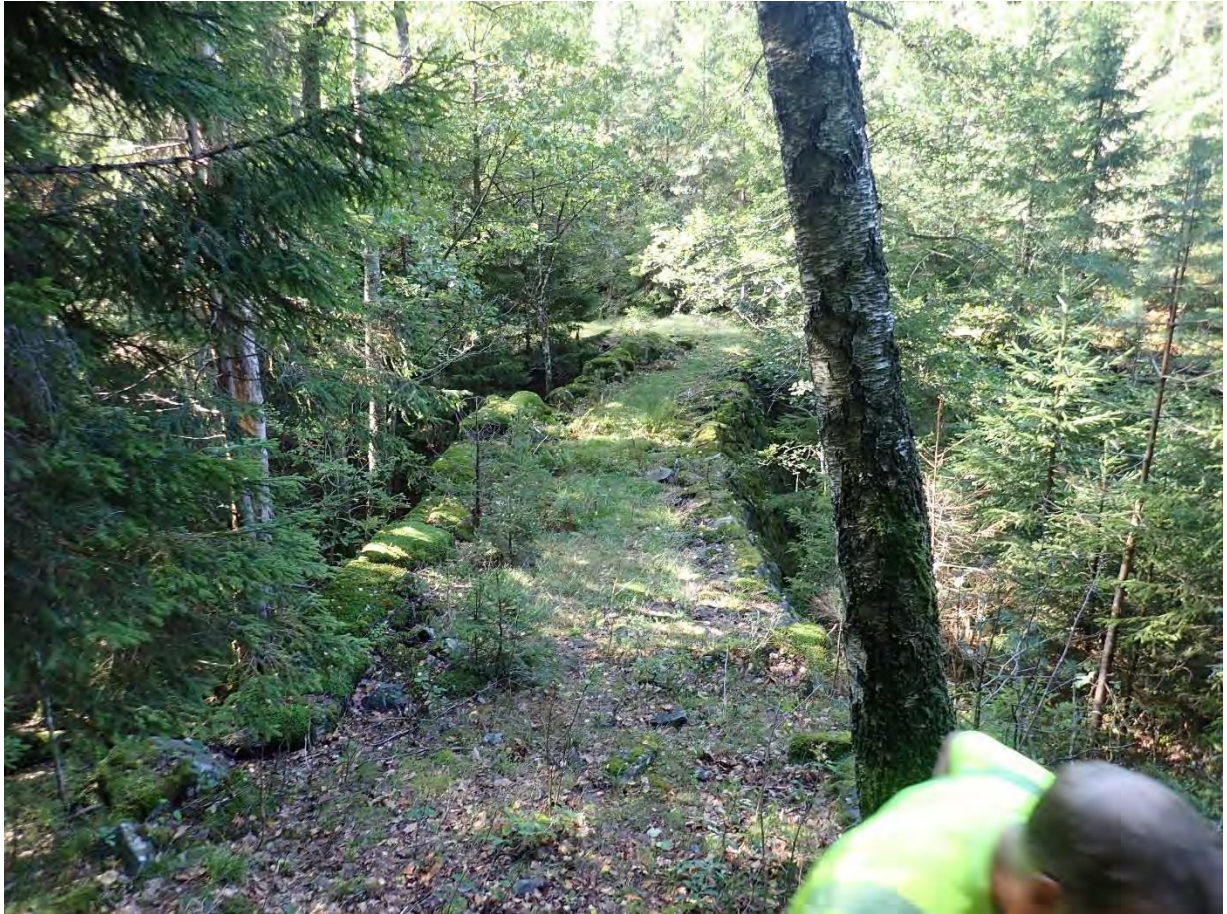
Figur 27. Gammel murdam sett fra høyre landfeste.
