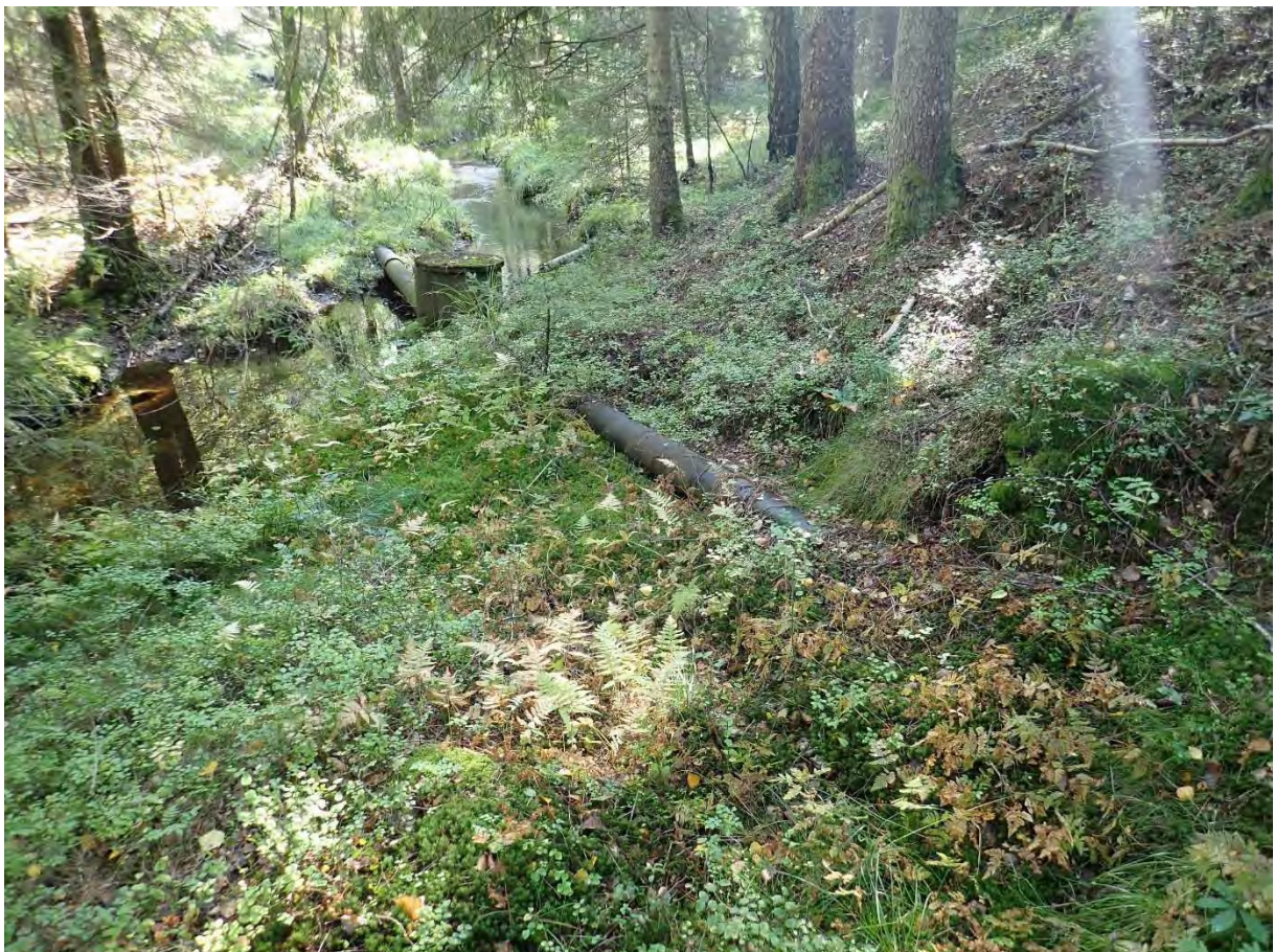
Figur 24. Pumperør og kum like oppstrøms for gammel dam i Gartebekken.
