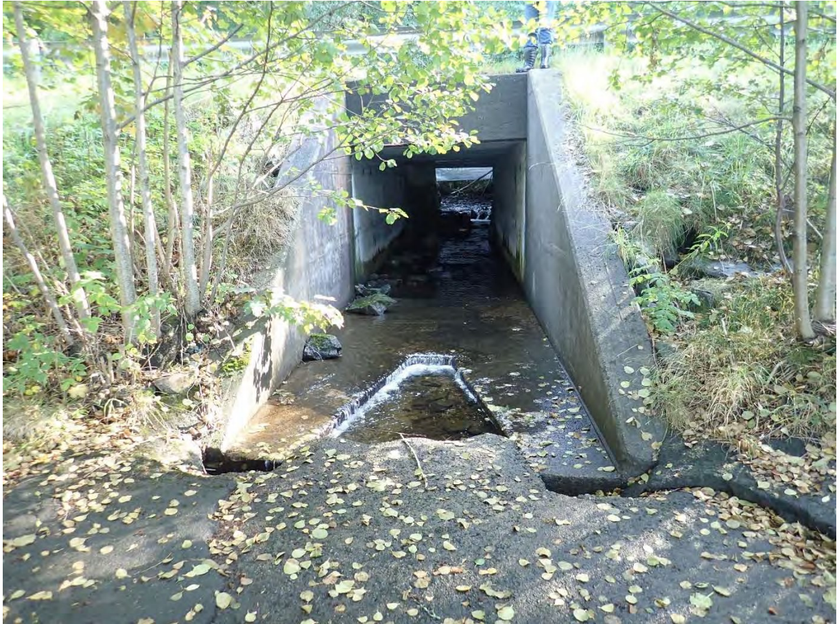
Figur 29. Kulvert under FV416 sett fra nedstrøms.
