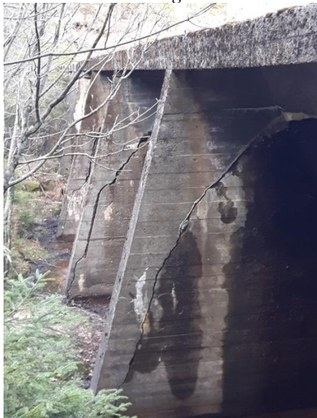
Bakkant demning sett mot øst:
