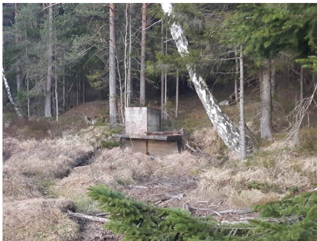
Liten betongkonstruksjon ved avstengt tunnelforbindelse, østlig vik
