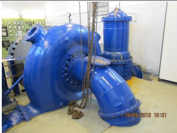
Turbin med hovedstengeventil
