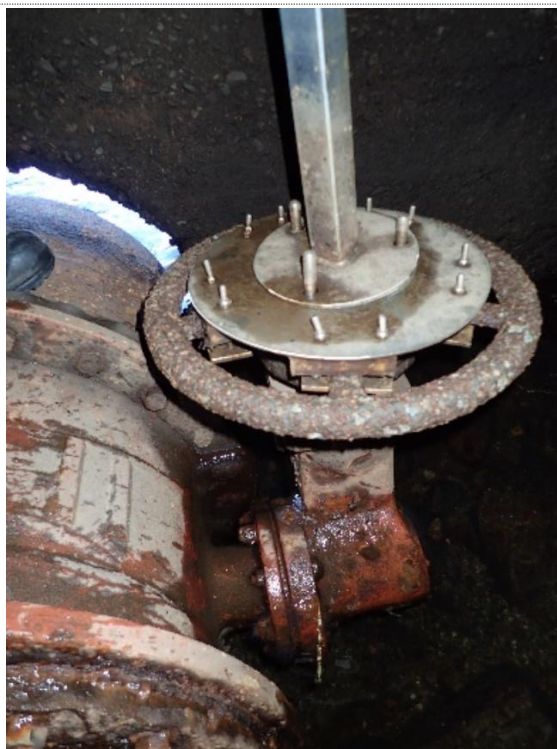
Hydraulisk pådrag på tappeventil
