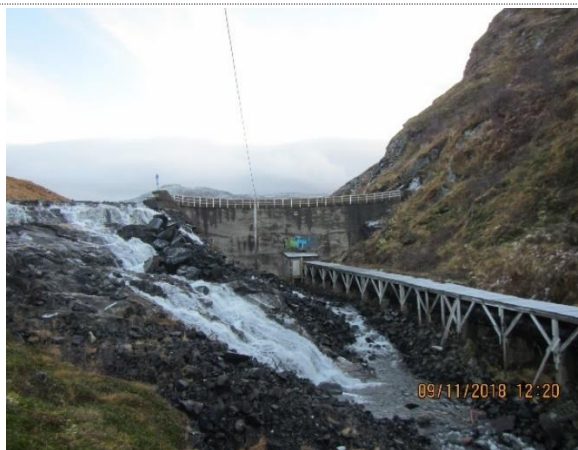
Dam Nedre Eggevatn med ventilkammer
