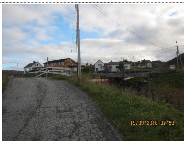
Kryssing av rørgate under riksveibru
