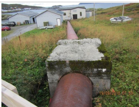
Rørgate sett ned mot kraftstasjon
