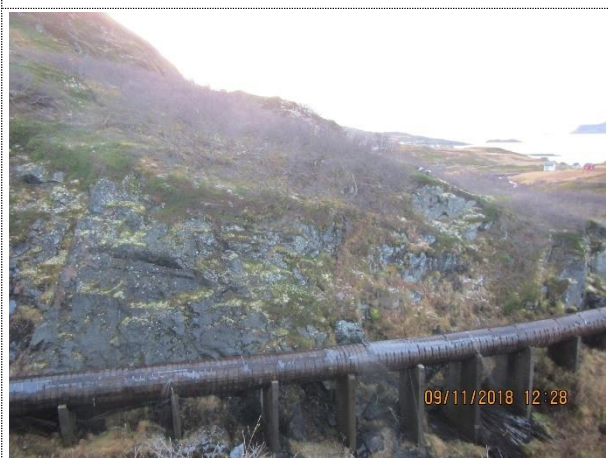
Rørgate ned mot sving
