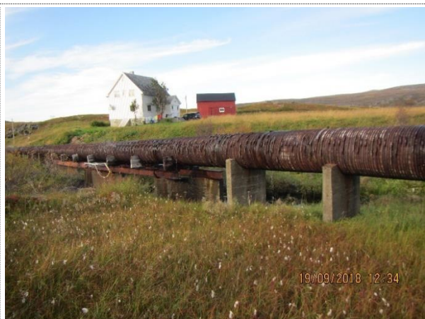
Rørgate med rørbru sett nedover mot riksvei
