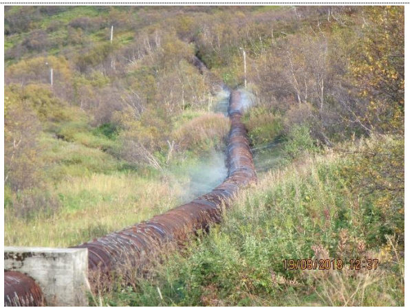
Rørgate opp mot sving
