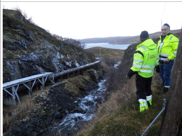
Rørgate parallelt med elveleie langs juv
