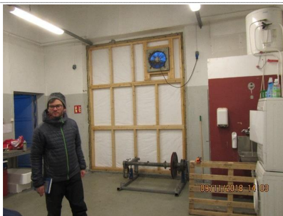
Adkomstport inn til kraftstasjon
