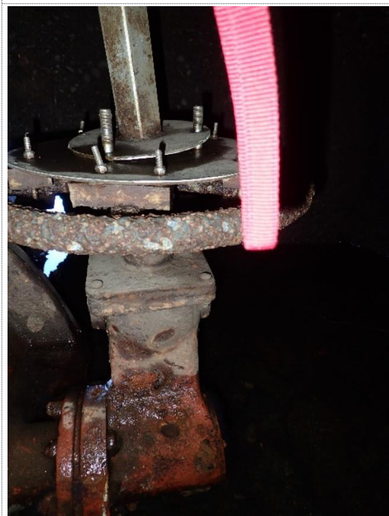
Hydraulisk pådrag på tappeventil
