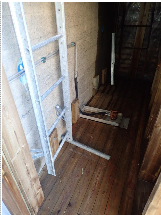
Hydraulikkør fra tappeventil
