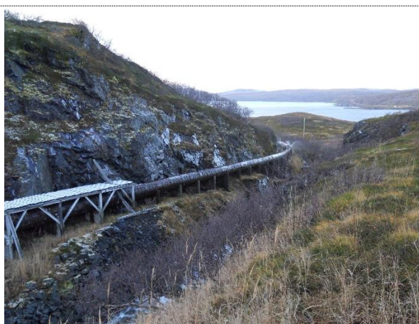
Rørgate ned mot sving
