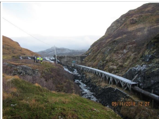
Øvre strekning av rørgate
