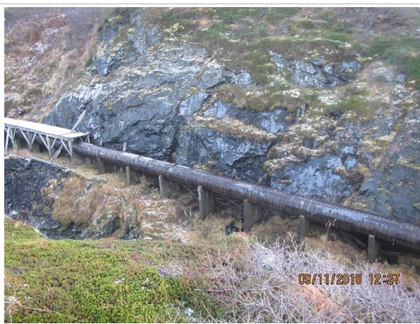
Øvre strekning av rørgate
