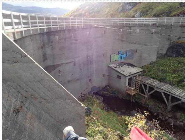
Dam Nedre Eggevatn med bunnappeløp og ventilkammer
