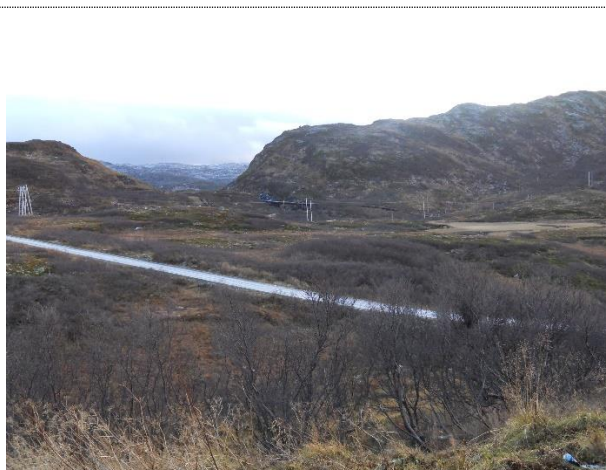
Adkomstvei opp til dam Nedre Eggevatn, rørgate i bakgrunnen
