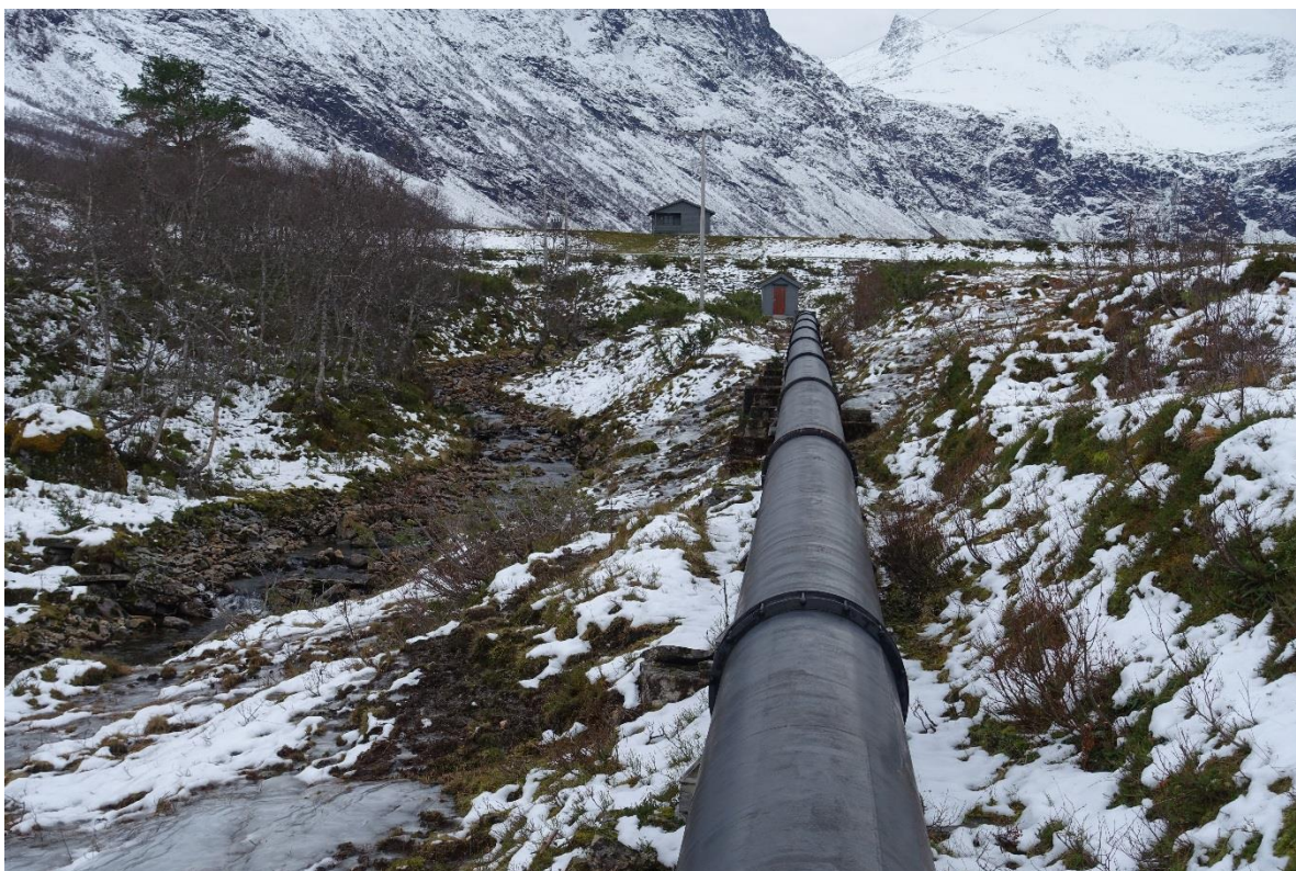
Figur 05. Eksisterande rørleidning, stålrør på bukkar, og lukehus og demning sett frå nordvest mot søraust.
