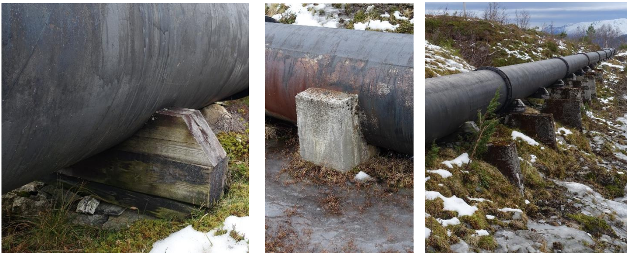
Figur 07. Eksisterande trykkrøyr er fundamentert hovudsakleg på tresliss/bukkar på eit nedre fundament av naturstein eller betong. Desse skal fjernast i lag med eksisterande røyrgate.
