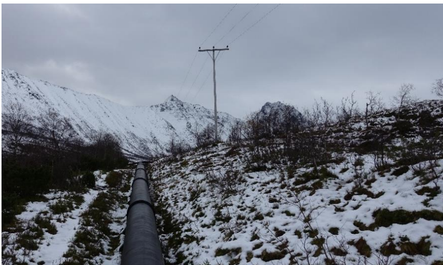
Figur 09. Langs eksisterande røyrgate går det ei 22 kV høgspenstline. Høgspenststolpane oppe ved demninga ligg på nordsida av røyrgata, før dei kryssar røyrgata og følgjer denne nedover på sørsida.
