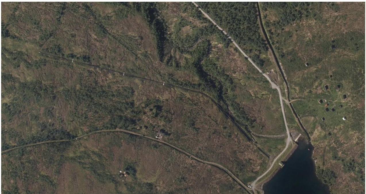
Figur 03. Flyfoto av området frå 2015 (Gislink). I høgre hjørne ser ein fritidsbusetnaden (sel) på Kvanndalssetra og demninga. Nordvest for demninga ser ein tydeleg eksisterande røyrgate som ligg over terrenget, samt kvar dette sluttar og går inn under bakkenivå. Ein ser og godt dei to overføringskanalane.
