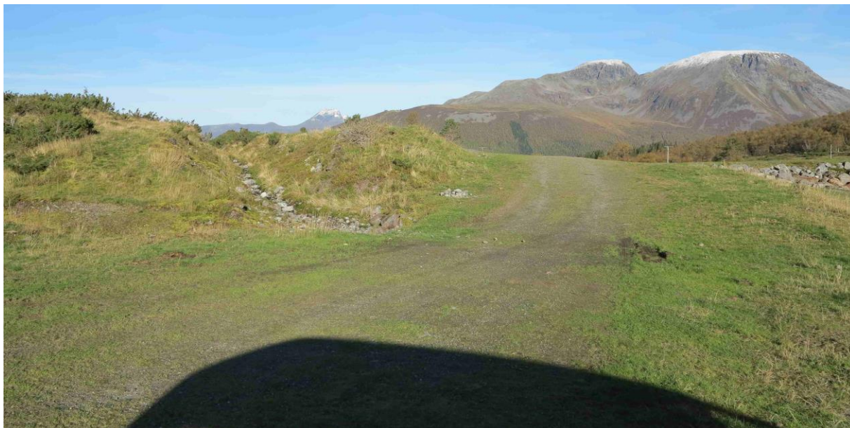
Figur 10. Foto; Oddvar Olsen for Bioreg AS © 05.10.2016. Litt til venstre for midten av dette biletet kan ein sjå samlegrøfta som kjem inn frå vestsida av røyrгата. Meininga med desse grøftene er å syta for at mest mogleg av nedbøren i området hamnar i Kvanndalsvatnet. Grøftene vart opphavleg gravne i 1940, men har truleg vore reinska også seinare. Elles skimtar ein så vidt demninga ute i høgre kanten av biletet. Stolpane som ein ser der går langs røyrгата.
