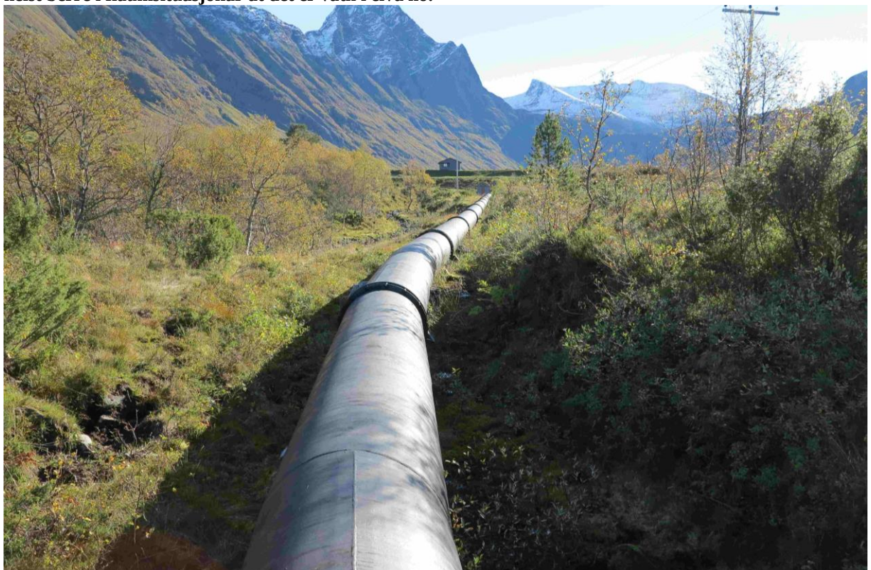
Figur 12. Foto; Oddvar Olsen for Bioreg AS © 05.10.2016. Biletet viser øvste delen av røyrkata slik ho er no. Som ein ser så er det to røyrlengder som har ein tydeleg knekk her. Det er meininga at det nye røyret skal få ei meir avrunda utforming, noko som medfører at den nye røyrtraseen kjem noko meir til høgre enn på dette biletet.
