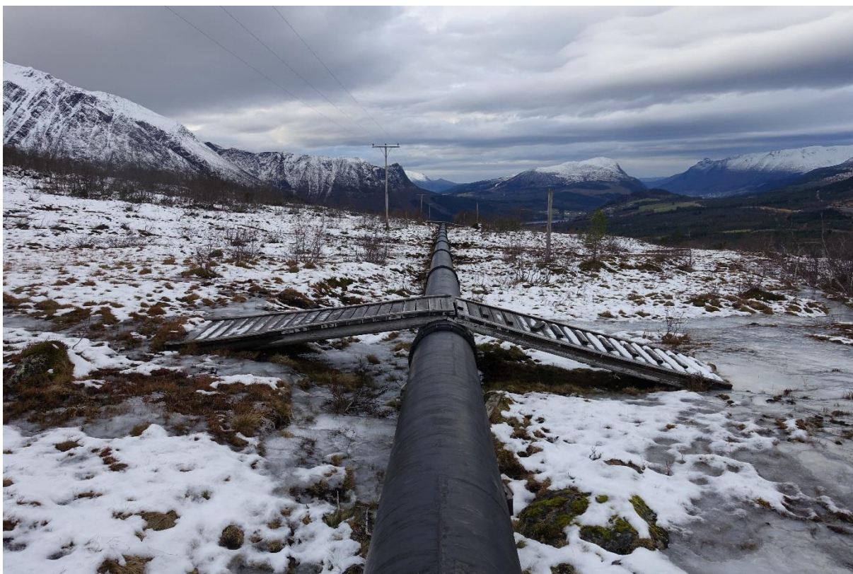
Figur 17. Ny rørgatetråse er planlagt til venstre for eks. rørgate. Som ein ser ligg eks. stolpar i ny rørgatetråse.
