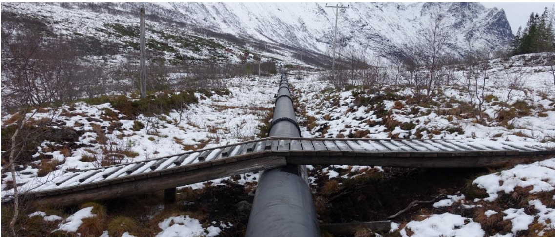
Figur 08. Det er lagt ut 3 stk kryssingsrampar på tvers av nedre del av stålørret.
