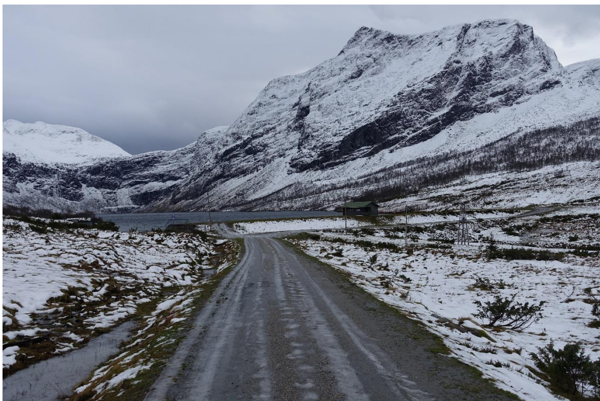
Figur 04. Eksisterande demning ved Kvanndalsvatnet, lukehus og røyrgate.
