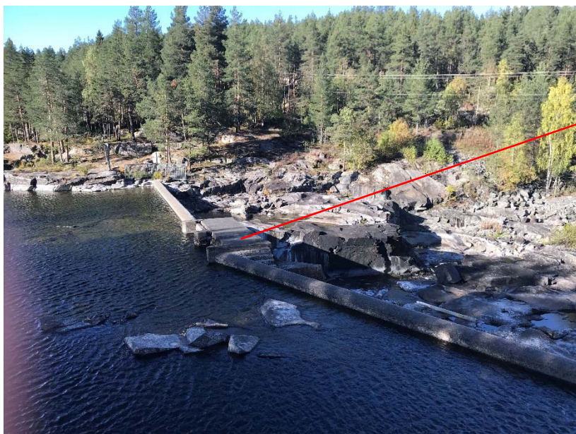
Bjelkestengsel og terskel sett fra vestsiden.
