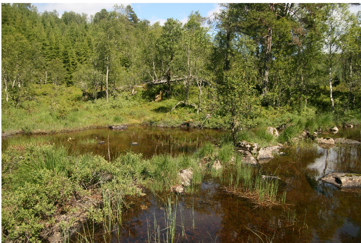
Figur 2-4 Lav løsmasseterskel i utløpet av Kaldbergsvatnet.
